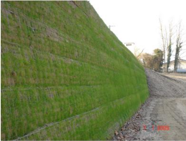
Photo c. Fin de construction.
