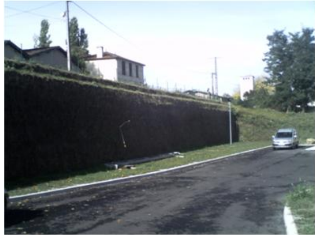
Photo d. 1 an après de la construction.
