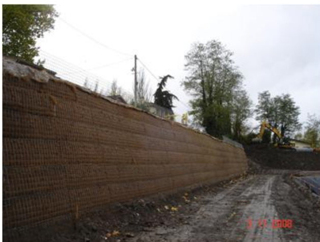
Photo a. Construction en cours de réalisation.
