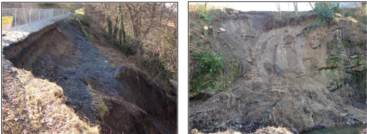
Figure 6. Photos du glissement de la voirie (Petit-Maire, 2009).
