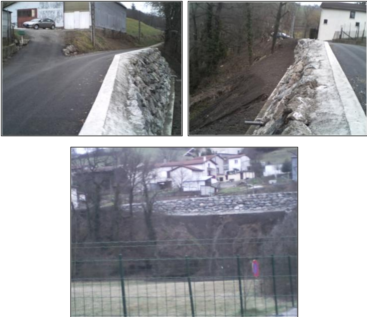
Figure 10. Photos montrant le mur de soutènement après construction.
