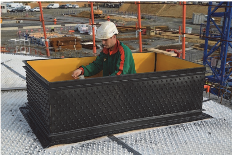
Figure 28. Trou d'hommes préfabriqué en attente de coulage Figure 29. Trous d'écarteurs de banches
