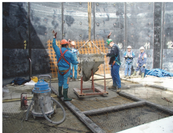
Figure 16. Coulage du béton
