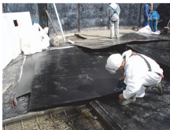
Figure 18. Découpe des plaques
