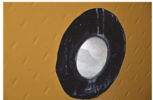
Figure 26. Passage de tuyauterie
