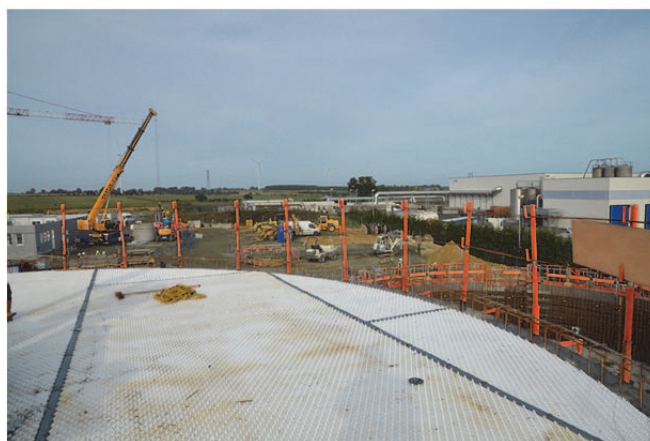
Figure 23. Vue des plaques avant bétonnage
