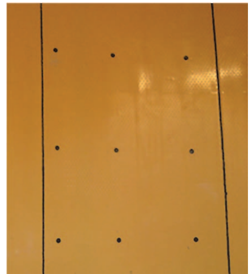
Figure 28. Trou d'hommes préfabriqué en attente de coulage Figure 29. Trous d'écarteurs de banches
