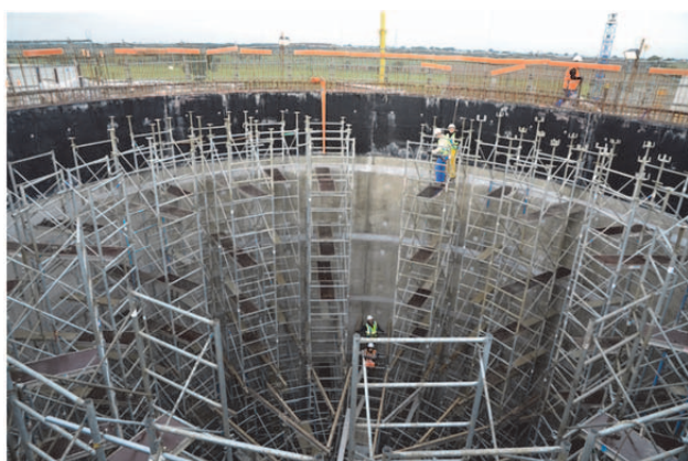
Figure 22. Étaie de la dalle de couverture
