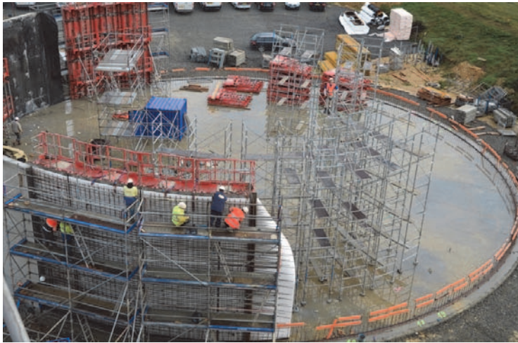
Figure 8. Pose de l'étanchéité sur le coffrage
