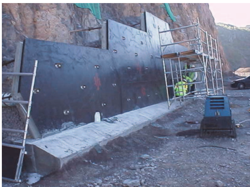
Figure 32. Etanchéité d'une paroi rocheuse
