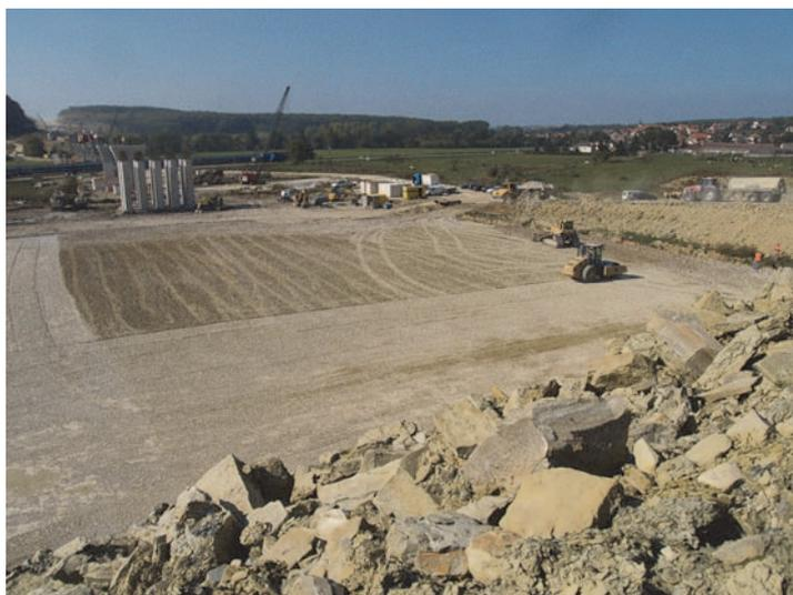
Figure 8. Terrassements de la base du remblai
