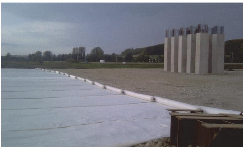
Figure 9. Mise en place des nappes de géosynthétique
