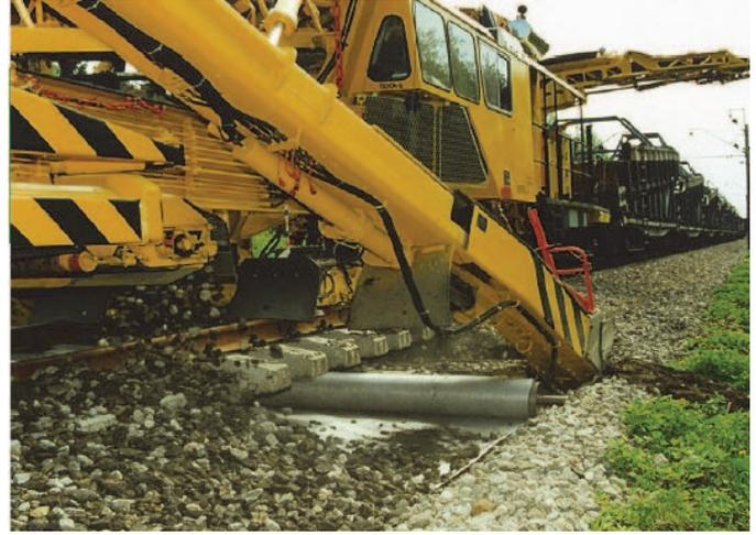
Figures 4 et 5. Mise en œuvre de géotextile sous ballast en Russie.
