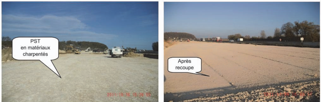
Figure 7. Mise en place du PST et de la couche de forme
