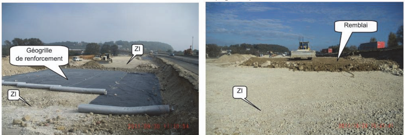
Figure 6. Mise en place du matelas ZI renforcé et du remblai
