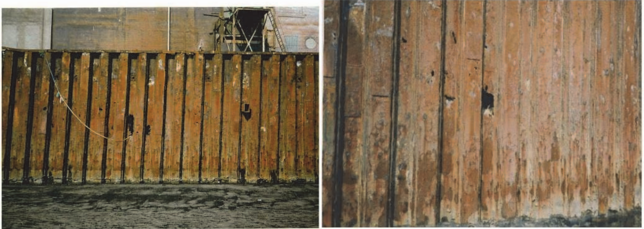
Figure 1. Présence de nombreux trous dans la structure existante
