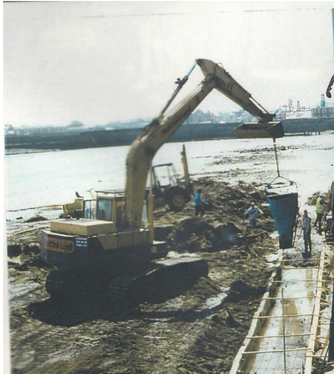
Figure 6. Mise en œuvre de la semelle de fondation des éléments modulaires
