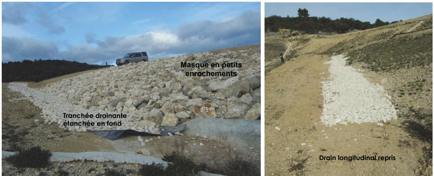
Figure 5. Illustration des travaux de réparation réalisés en décembre 2011 (partie haute)
