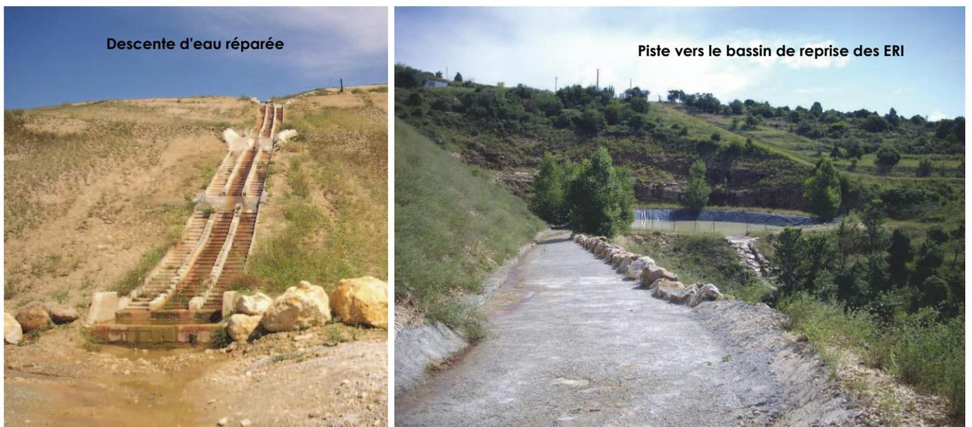
Figure 6. Illustration des travaux de réparation réalisés en décembre 2011 (partie basse)
