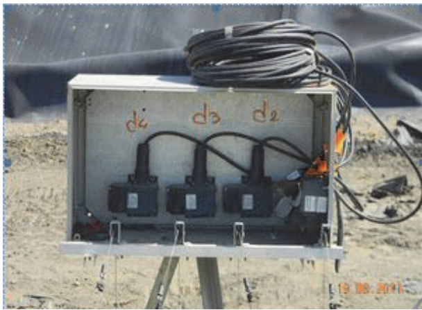
a. Capteurs de déplacement installés sur la première risberme
