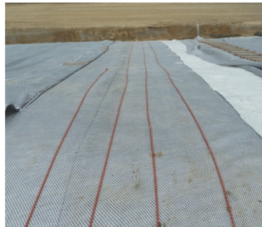
b. Câbles de connexion pour la mesure du déplacement
