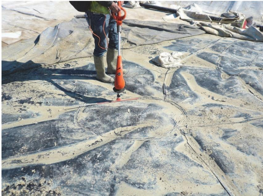
Figure 6. Second passage du balai après réparation.
