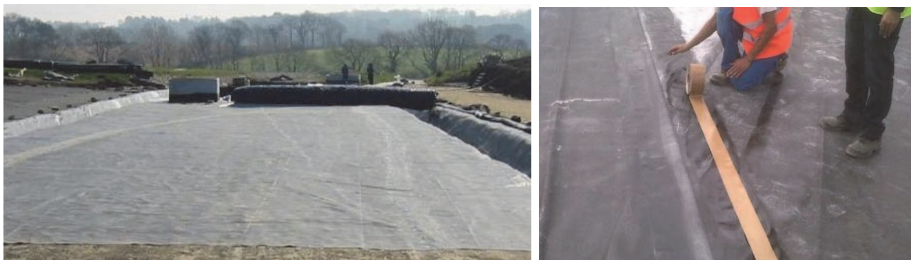
Figure 6. Installation de la géomembrane EPDM. Réalisation d'un joint à l'aide d'une bande autoadhésive
