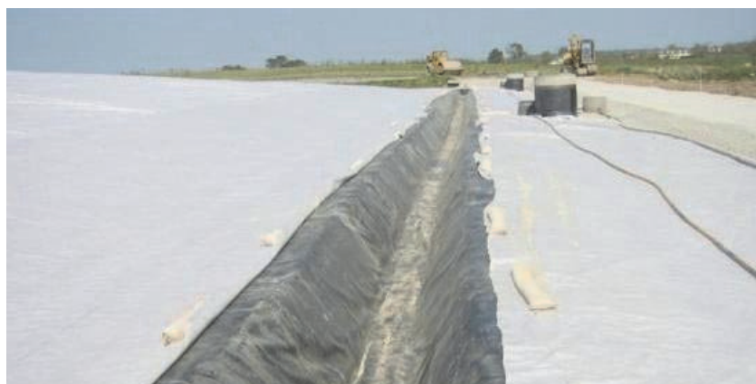
Figure 4. Installation du fossé périphérique et du géotextile de protection supérieur
