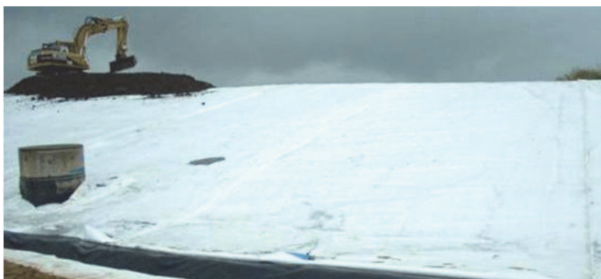
Figure 5. Mise en œuvre du sol de couverture
