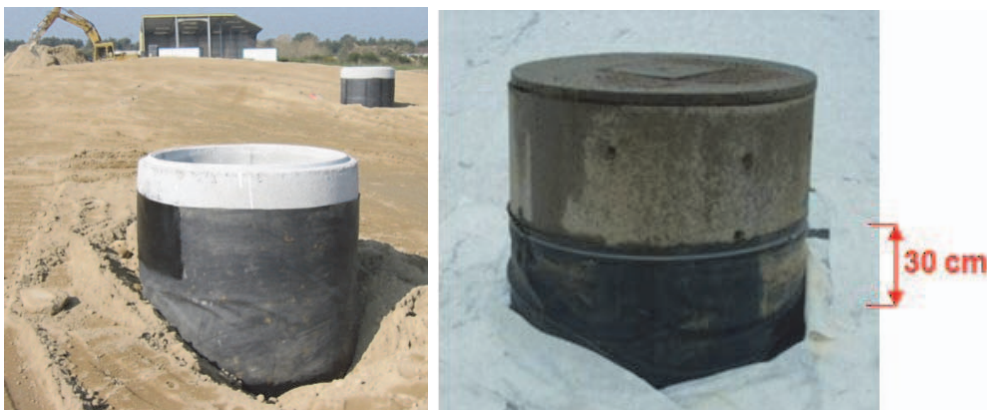
Figure 10. Puits de dégazage avant et après la réalisation du pli d'aisance
