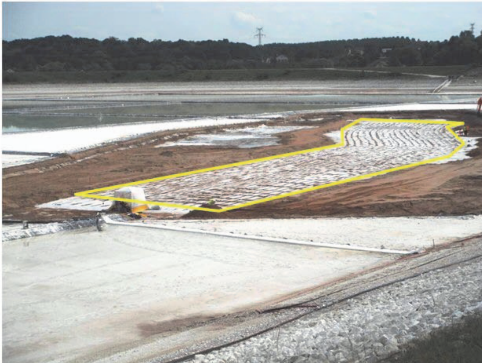
Figure 6. Vue depuis la crête de digue du bassin et de la zone instrumentée (en clair au centre)
