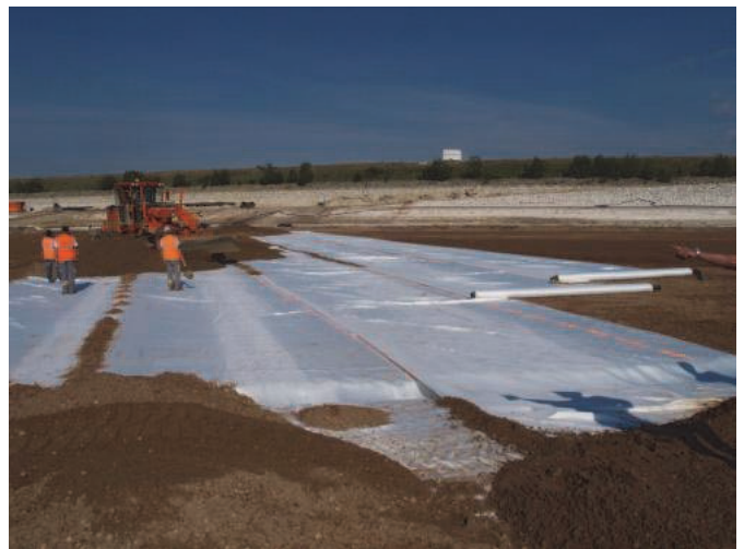
Figure 7. Pose de bandes capteur en fond de bassin (à gauche), recouvertes par la couche d'alluvions 0/16 et par le géotextile de renforcement (à droite)
