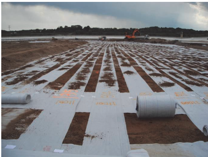
Figure 7. Pose de bandes capteur en fond de bassin (à gauche), recouvertes par la couche d'alluvions 0/16 et par le géotextile de renforcement (à droite)
