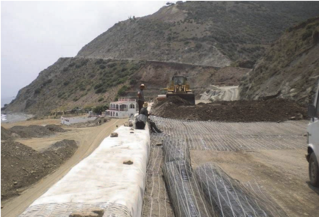
Figure 5. Réglage d'une couche de remblai
