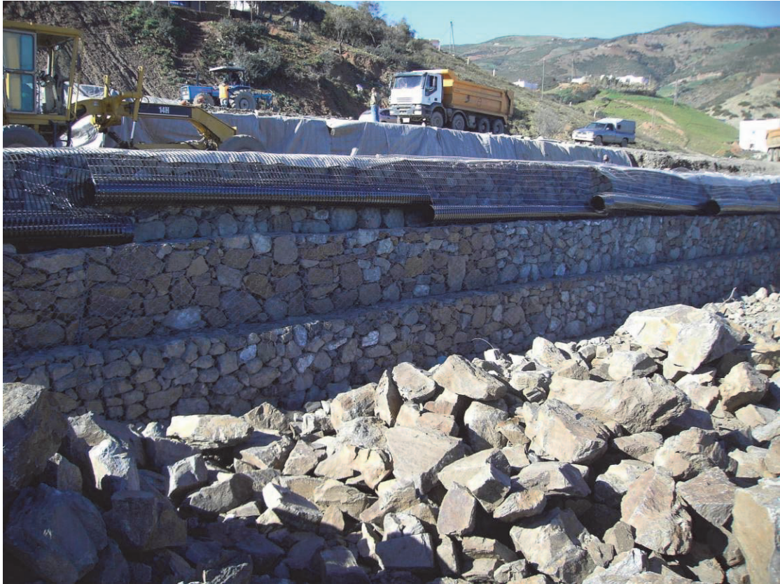
Figure 2. Vue des géogrilles de renforcement et du parement en gabions incliné à 63 degrés
