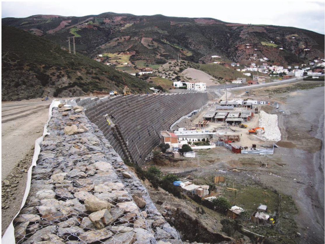
Figure 3. Vue générale d'un mur fini
