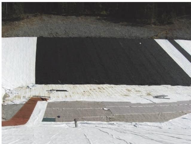
Figure 9. Mise en place des différentes couches sur la retenue des Orres
