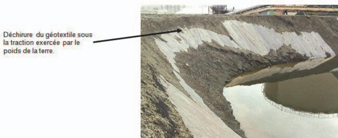
Figure 5. Un accroche terre insuffisamment renforcé peut se rompre sous le poids de la couche de matériaux de couverture
