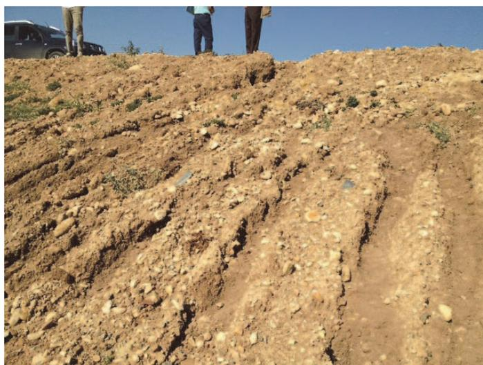
Figure 1. Érosion des matériaux sur un talus en absence de barrières filtrantes accroche terre
