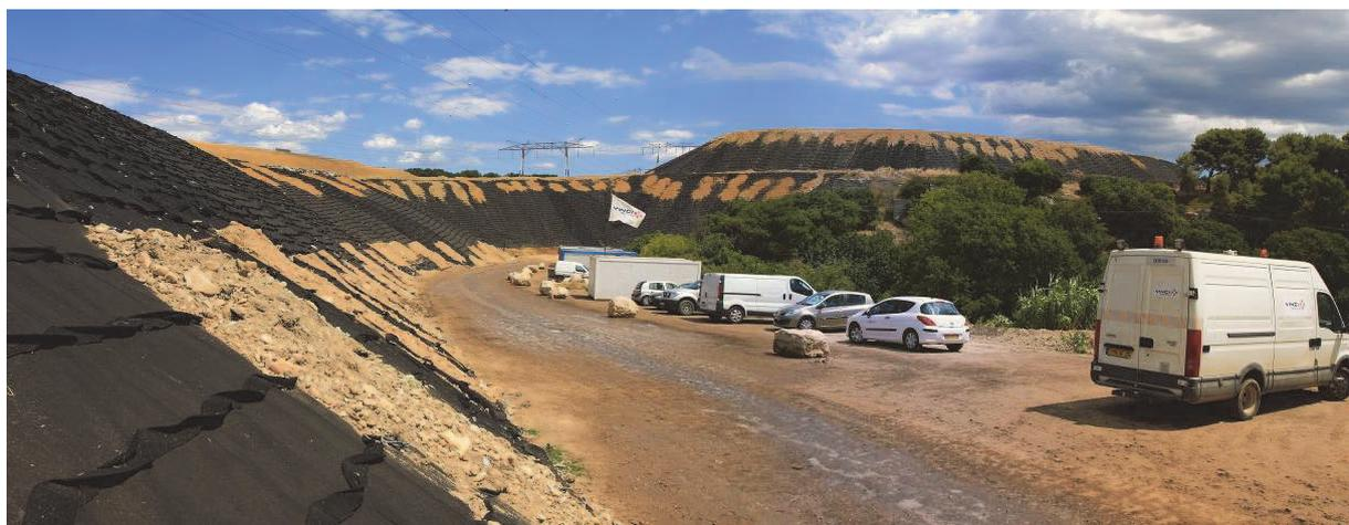
Figure 8. Mise en place des matériaux sur le géocomposite
