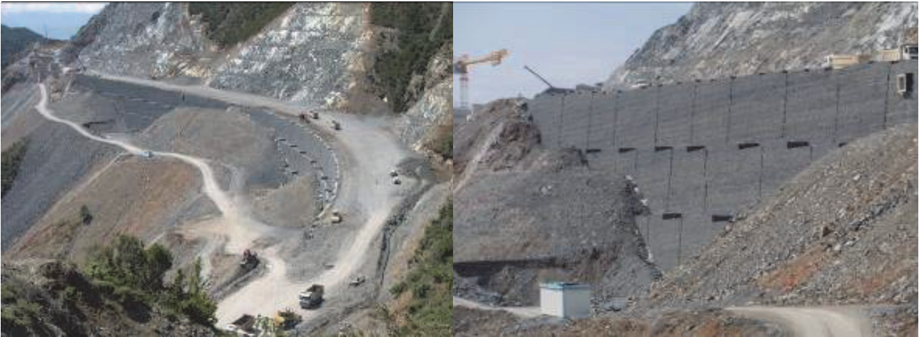
Figure 11. Projet autoroutier entre Rreshen et Kalimash, Albanie – Vue de la structure en construction et une fois terminée
