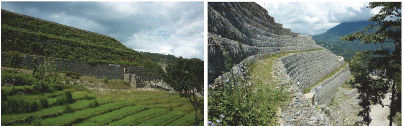
Figure 13. Photographies de l'ouvrage fini
