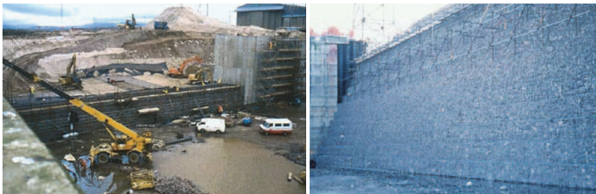
Figure 7. Nigg, UK – Ouvrage en cours de réalisation et une fois terminé
