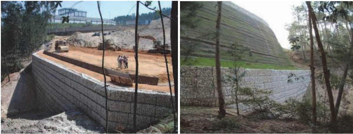
Figure 9. Leiria, Portugal – Vue de l'ouvrage en construction et une fois terminé
