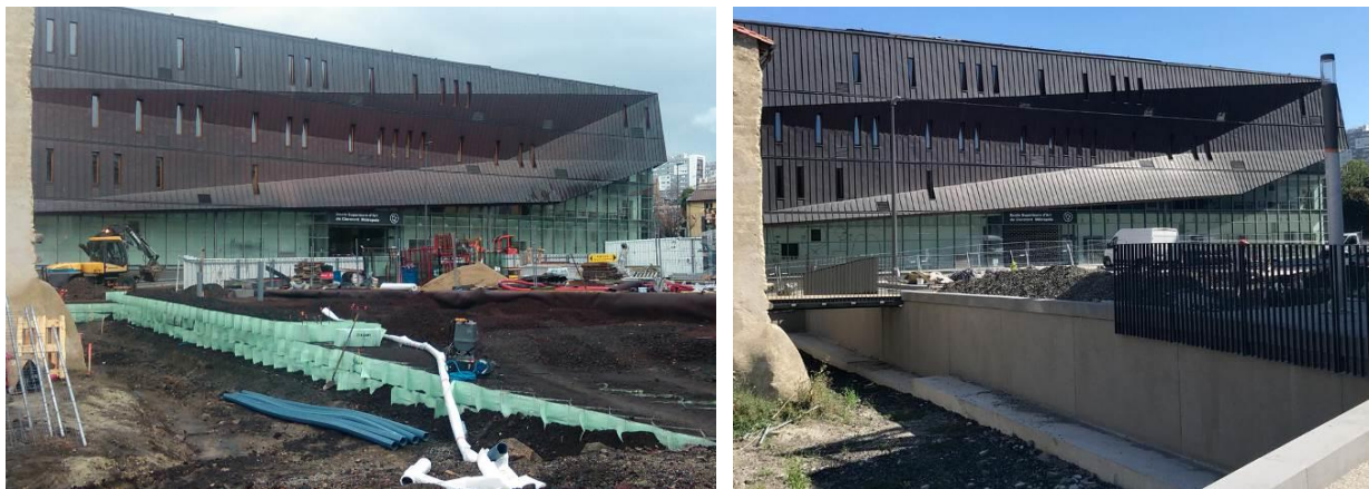
Figure 1. Vues de l'ouvrage
