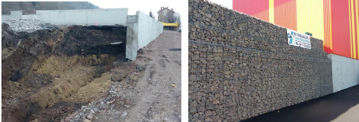
Figure 3. Vues de l'ouvrage
