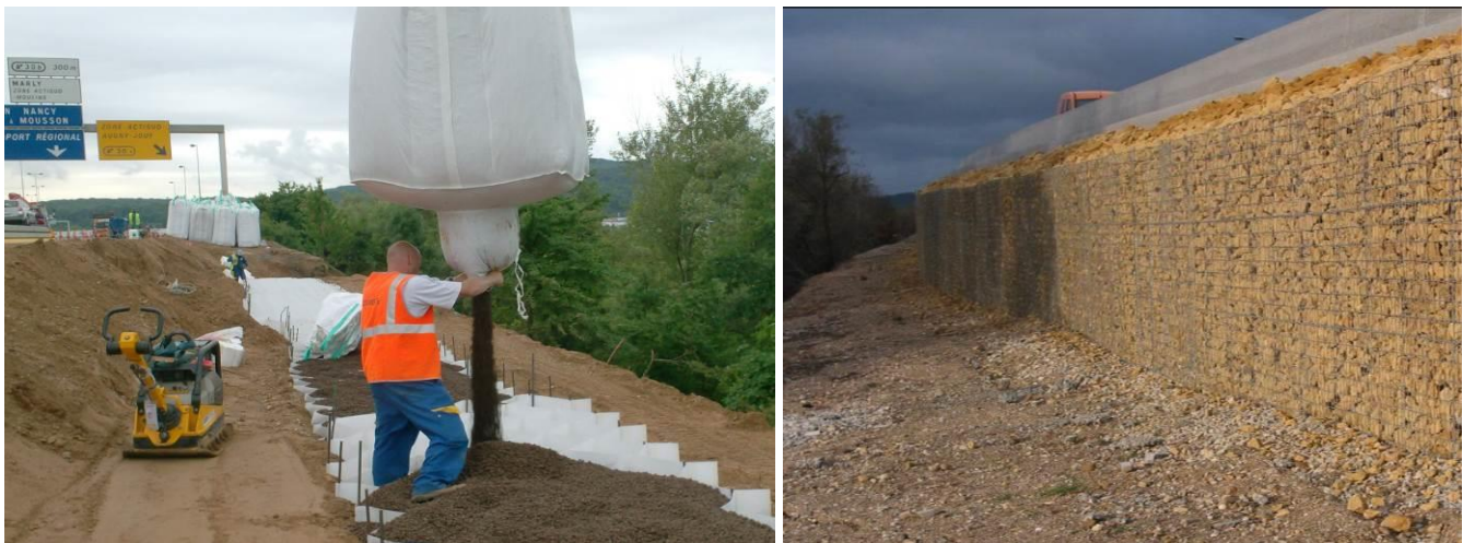
Figure 2. Vues de l'ouvrage
