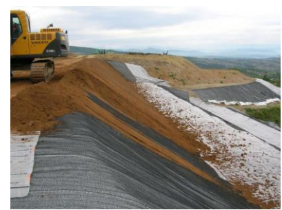
Stabilisation de terre sur flancs de casier, centre de stockage de déchets de Forcalquier (04) – Crédit Photo CFG
