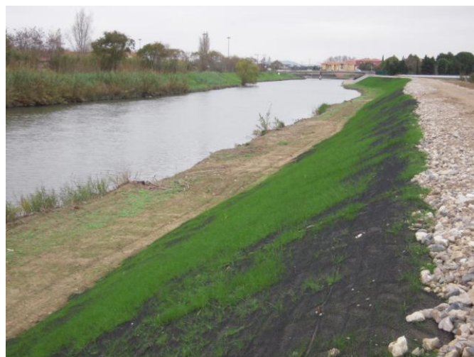
Digue de Protection contre l'érosion hydraulique et les inondations à Lattes (34) – Crédit Photo CFG
