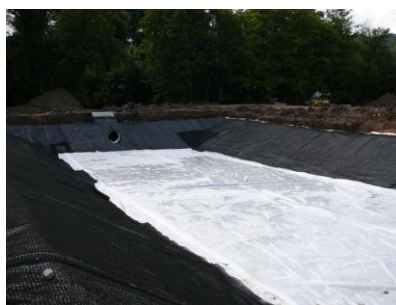
Géosynthétique de maintien de terre sur talus – Crédit Photo CFG
