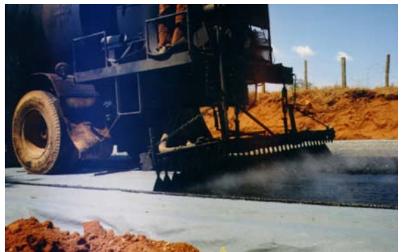
Géosynthétiques dans la construction d'une chaussée (*)
