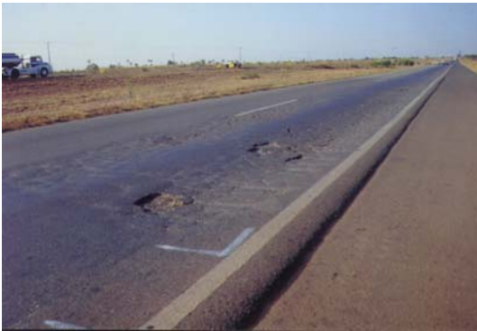
Endommagements sur une chaussée conventionnelle
