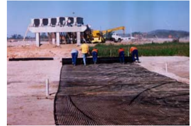
Rupture type d'un remblai non renforcé et utilisation de nappes géosynthétiques en renforcement
