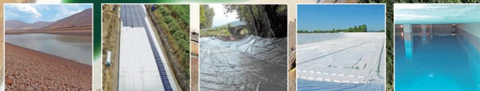
Les géomembranes **RENOLIT ALKORPLAN** assurent l'étanchéité des ouvrages hydrauliques utilisés pour le stockage de liquides de différentes natures (eau de pluie, lisier, eau usée, digestat, etc.)
