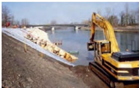
Figure 11. Géotextile de filtration sous enrochement (© TenCate).
