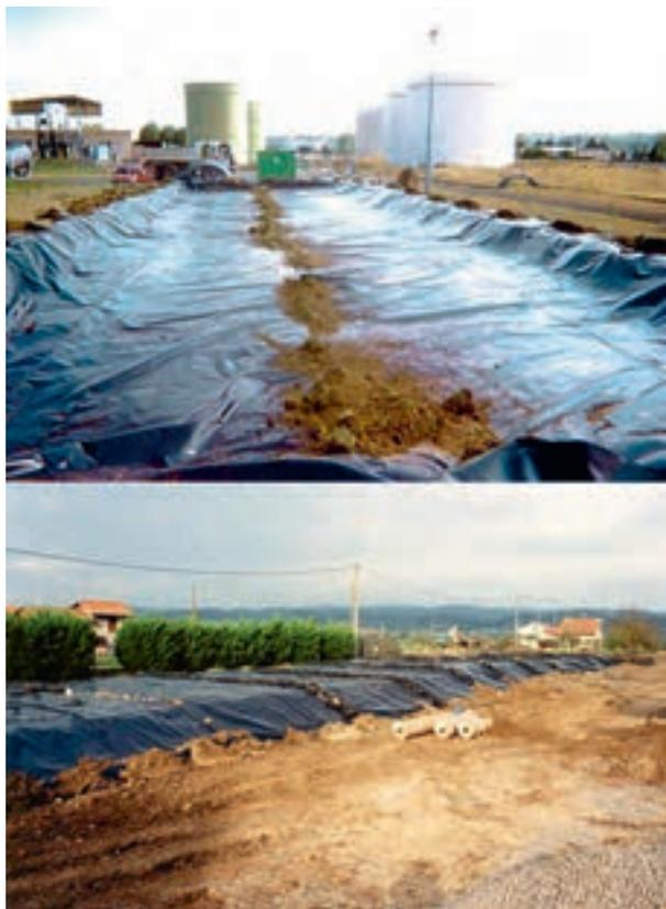
Figure 58. Fond et couverture de biotertres exposés aux intempéries : géofilm en polyéthylène (© Arcadis).
