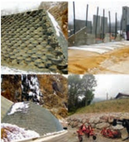
Figure 37. Différents types de parements possibles (non exhaustif) (© F. Roussy).
