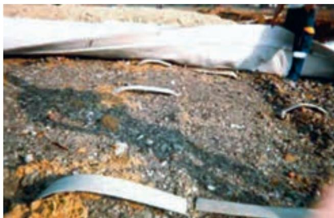
Figure 28. Pose du géocomposite de drainage au contact des drains verticaux (© Afitex).
