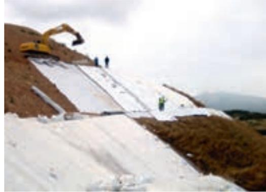
Figure 54. Installation des géosynthétiques sur le talus (© Arcadis).
