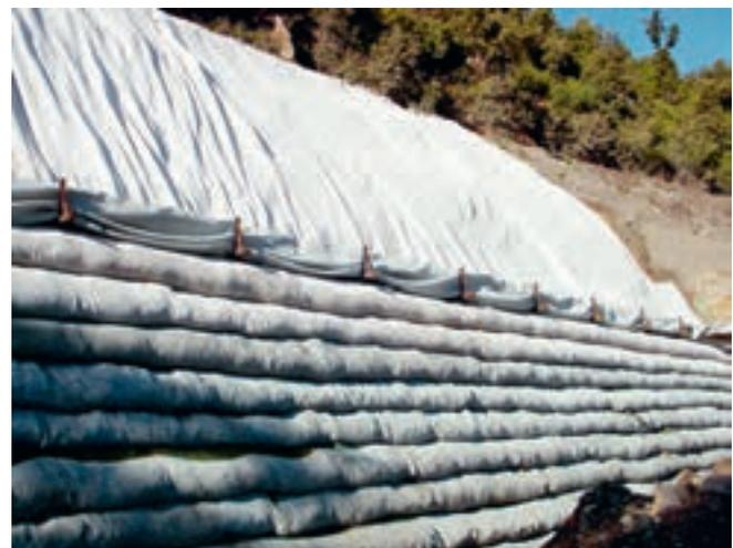
Figure 41. Profil type de position du géocomposite de drainage en talus renforcé (© Géoroute).
