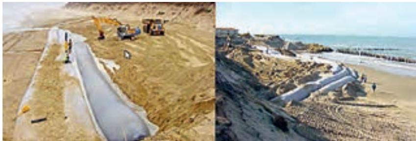
Figure 13. Photographie du chantier en tubes géosynthétiques de Port-Médoc (© O. Artières).
