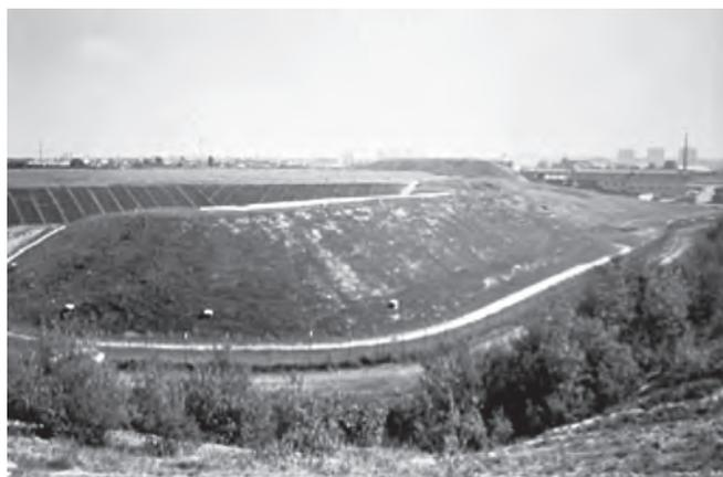
Figure 57. Annexe du « Grand terril de chrome » de Wattrelos : confinement « hors site » par géomembrane bitumineuse (© M. Ballie) [47].
