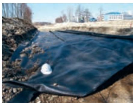
Figure 19. Utilisation d'un géotextile tissé en renforcement de couche de forme (© TenCate).
