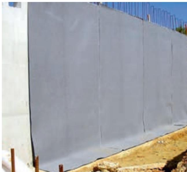
Figure 45. Étanchéité et drainage sur voile en béton banché ou maçonnerie (© Géoroute).
