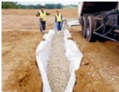
Figure 33. Filtre géotextile entre un matériau fin et un matériau drainant (© TenCate).
