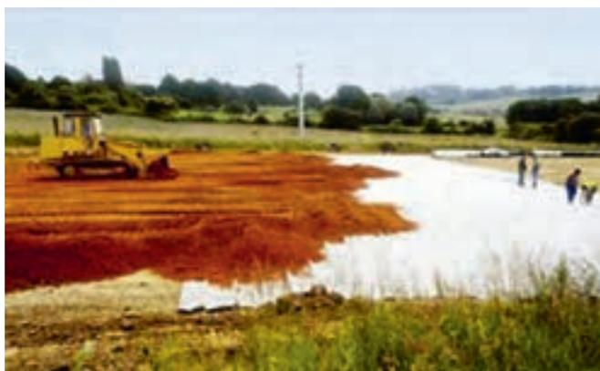
Figure 27. Mise en œuvre du remblai sur le géocomposite de drainage (© Afitex).
