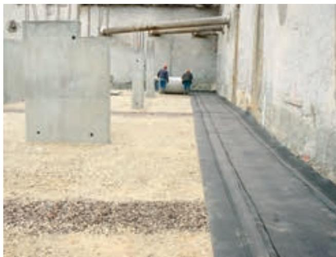
Figure 42. Installation d'un drainage sous dalle (© Géoroute).
