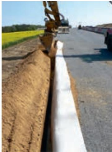
Figure 30. Géocomposite de drainage en EDRC (© Géoroute).
