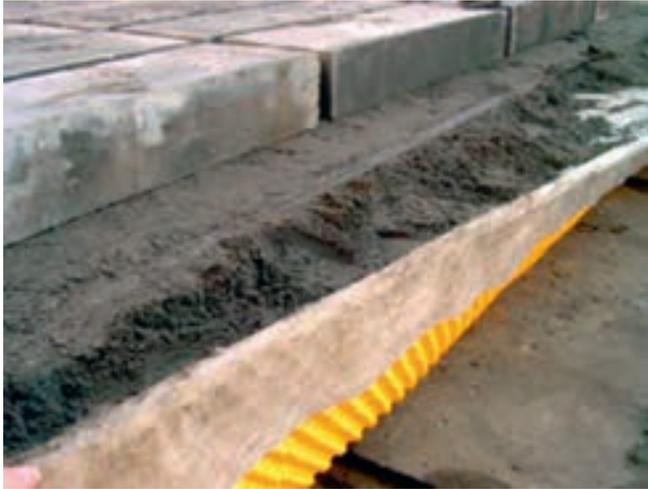
Figure 4. Exemple de géoespaceur (© Ryb Composites).
