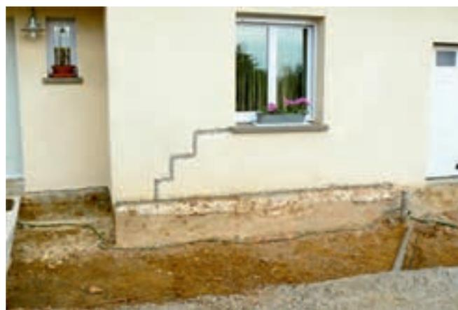
Figure 48. Fissure due à des gonflements d'argile (© Géoroute).
