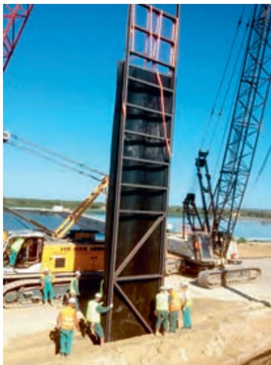
Figure 60. Mise en œuvre d'une palfeuille PEHD dans une tranchée au coulis bentonite/ciment (© J.-L. Meusy) [49].
