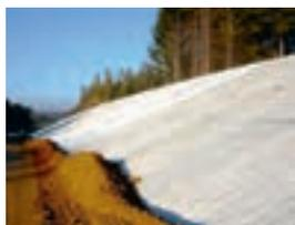
Figure 35. Géocomposite de drainage sur talus (© AfiteX).
