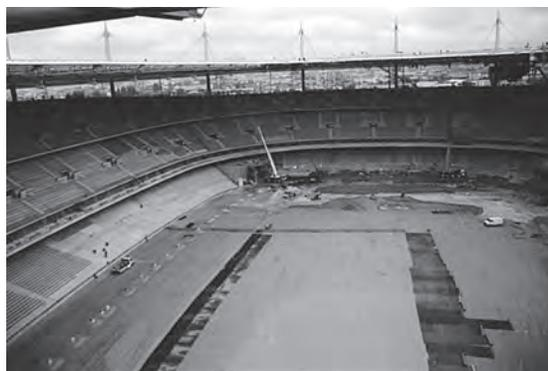
Figure 61. Mise en œuvre d'une géomembrane PVC pour favoriser l'aspiration des polluants volatils sous les pelouses du Stade de France (© A. Bourrassin) [50].
