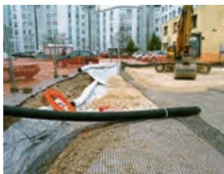
Figure 18. Utilisation d'une géogrille en renforcement de couche de forme (© TenCate).
