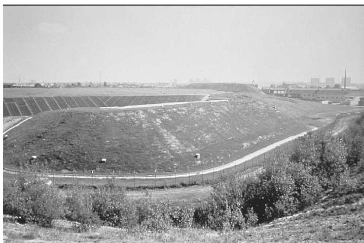
Le « Grand terriil de Cr VI » de Wattrelos : au premier plan, son annexe, rapportée en 1998, est un confinement « hors site » par géomembrane bitumineuse (Ballie et al. 1999)
