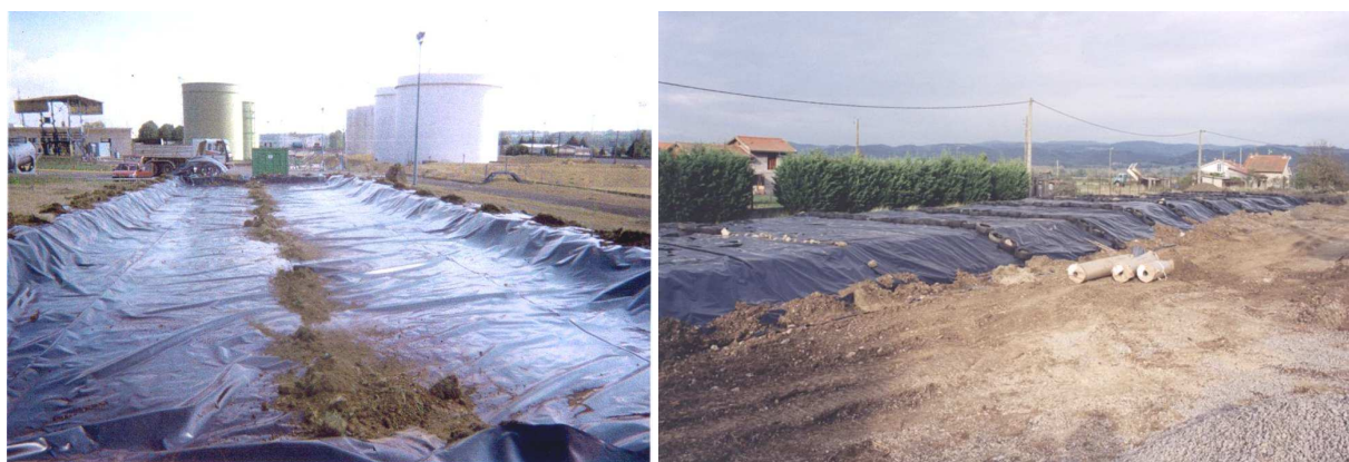
Dispositif basal et couverture de biotertres exposés aux intempéries : géofilm en polyéthylène
