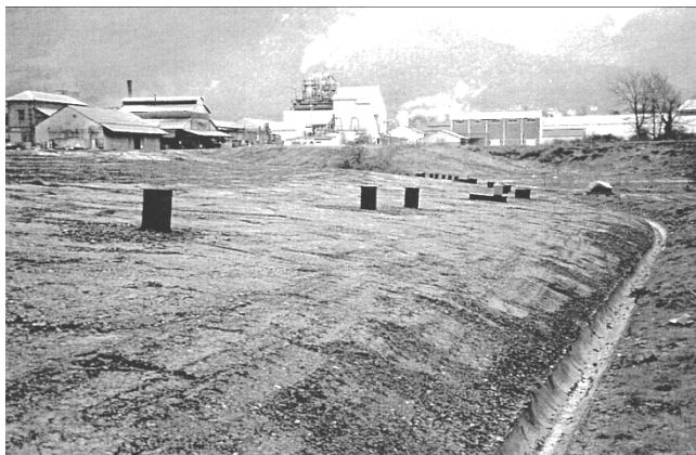
« Tombeau d'arsenic » étanché par géomembrane PEHD en 1997 (De Bont & Ouvry, 1999)
