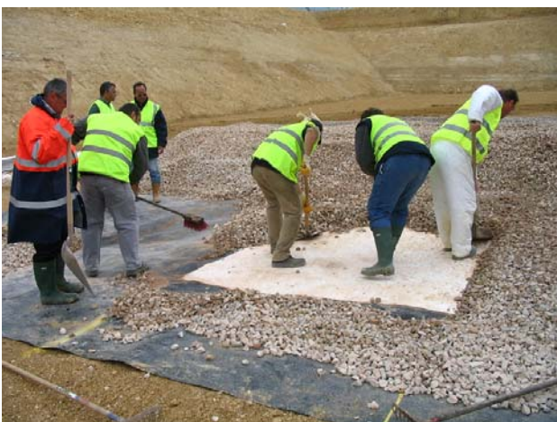
e/ Enlèvement des graviers
