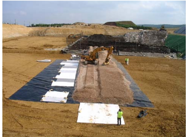
b/ Mise en place des graviers concassés
