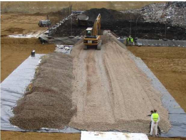
c/ Mise en place des graviers roulés
