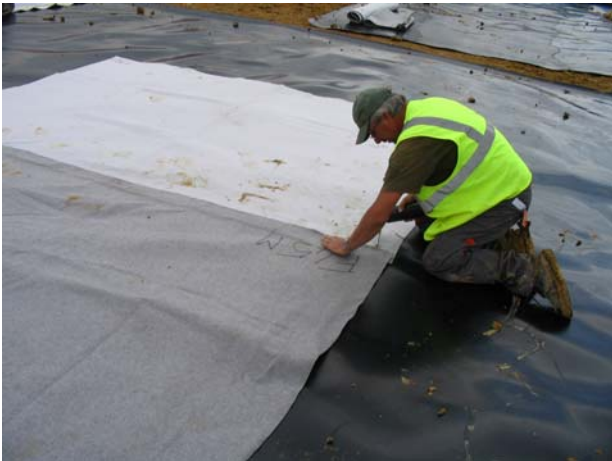
a/ Soudure des géotextiles
