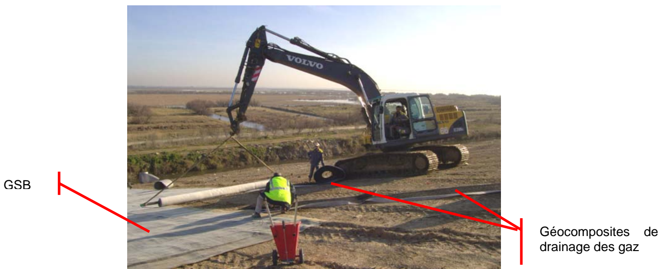
Figure 2. Pose du dispositif d'étanchéité - drainage
