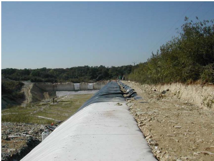
Photo 3. Vue de la tranchée d'ancrage en crête de talus
