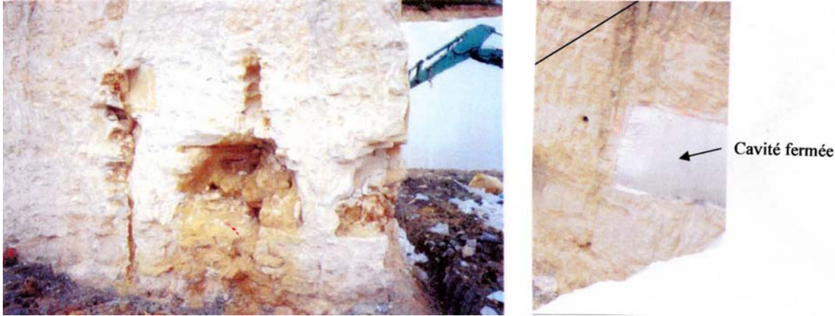
Photo 2. Cavités avant et après traitement
