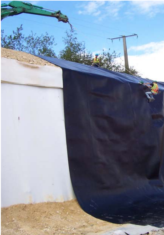
Photo 4. Mise en place de la géomembrane
