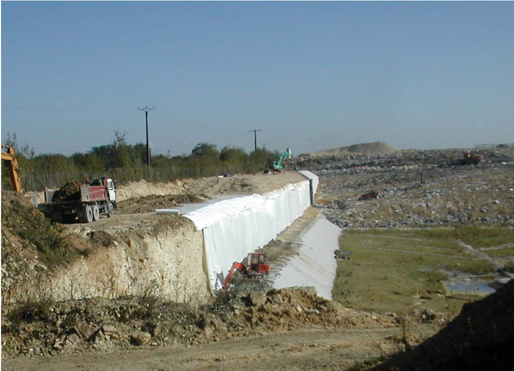
Photo1 : Vue générale sur le chantier
