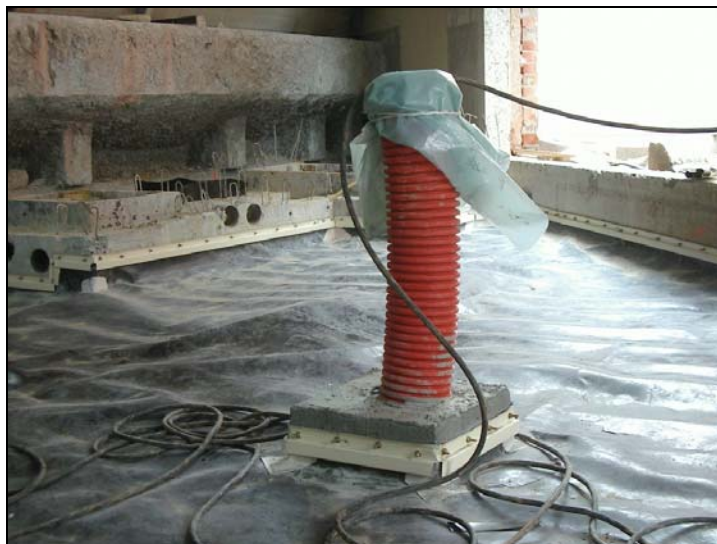
Photo n° 3. Détail de raccordement sur Gaine PE
