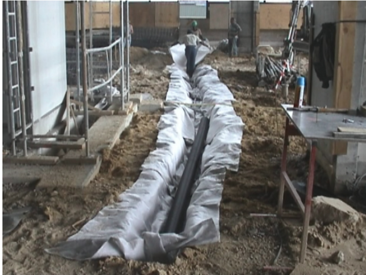
Photo n°5. Pose des drains PEHD en tranché
