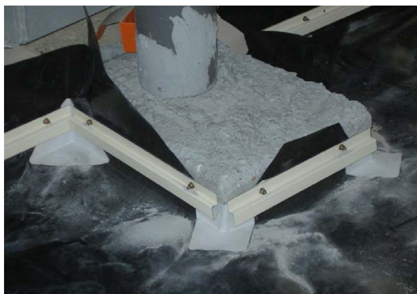
Photo n°4. Détail de fixation de la géomembrane sur béton avec réglette et pièces de renfort.
