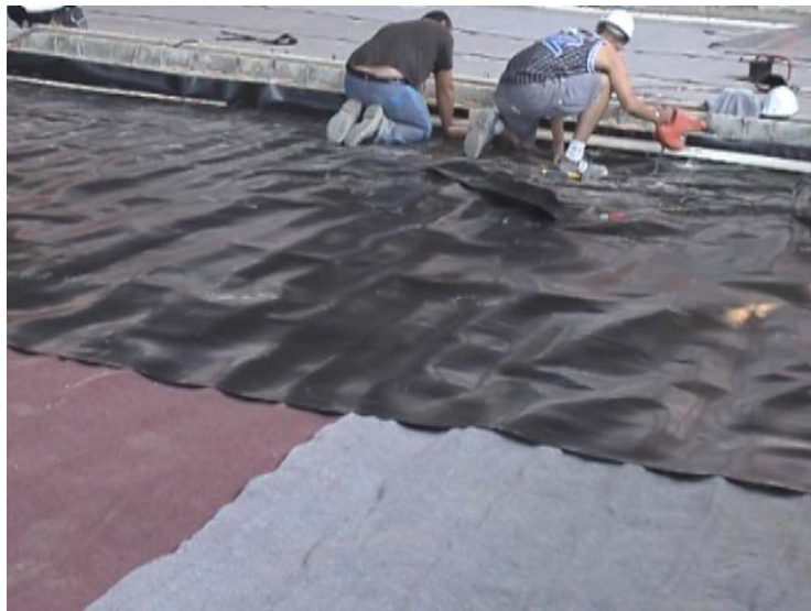
Photo n°6. Étancheurs effectuant la pose de réglets de compression pour un raccordement sur une longrine
