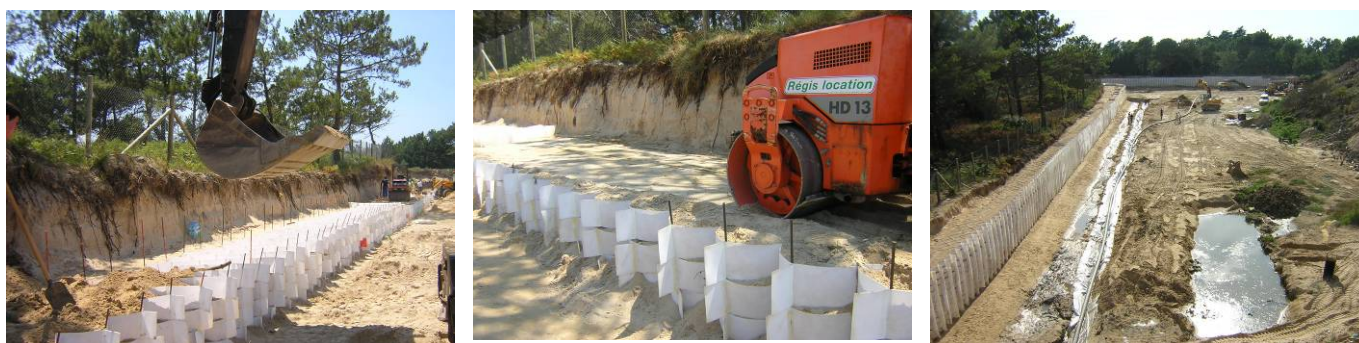
Figure 4. Photographies de construction de l'ouvrage
