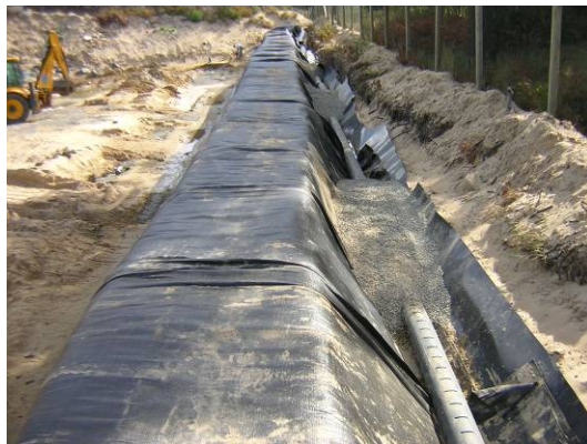
Figure 5. Photos de mise en oeuvre du complexe d'étanchéité
