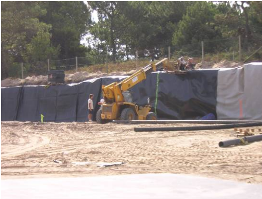
Figure 5. Photos de mise en oeuvre du complexe d'étanchéité
