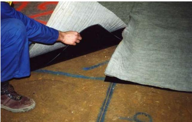
Figure 3. Vue du DEG sur support limon
