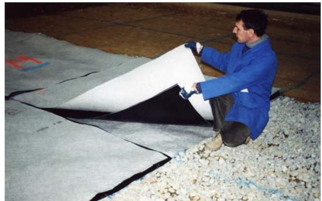
Figure 4. Vue du DEG sur granulats 20/40 mm
