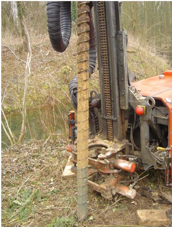
Photo 3. Forage pour la mise en place de l'instrumentation
