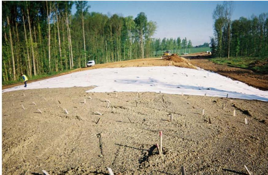
Photo 1. vue des drains verticaux et de la piste d'accès en 'toit'
