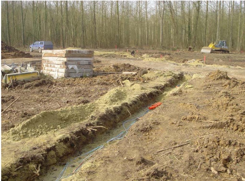
Photo 4. Mise en place de l'instrumentation
