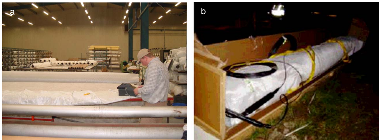
Figure 4. Préparation et conditionnement de la nappe géotextile
