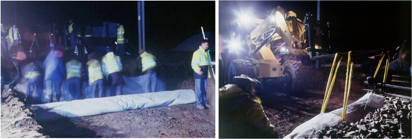
Figure 5. Mise en œuvre de la nappe géosynthétique
