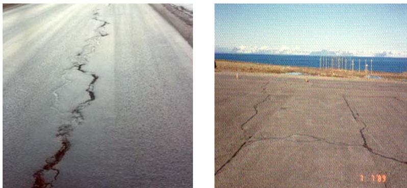
Figure 3. Exemples typiques, fissurations réfléctive et due au gel
