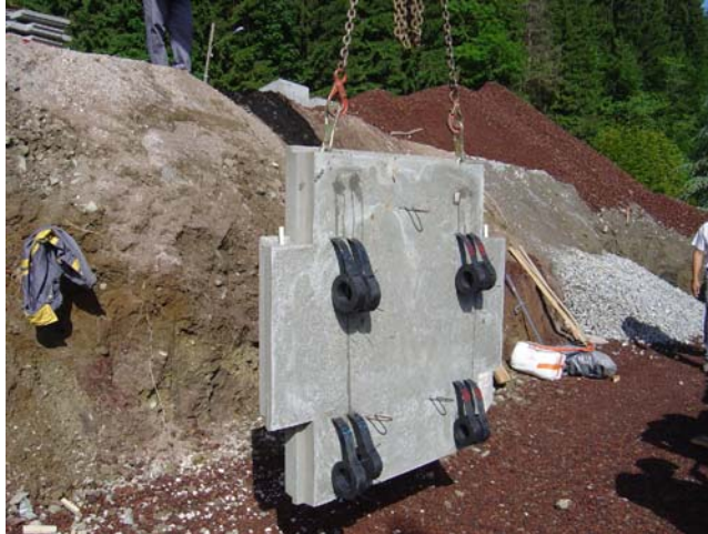
Figure 3. Ecaille à quatre connexions mise en œuvre sur le chantier.
