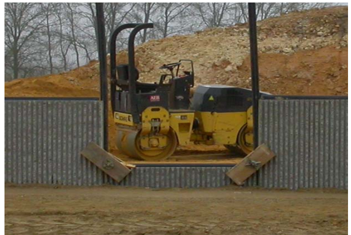
Figure 2 : fixation par serre-joints
