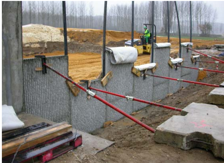
Figure 7. Contreventement des écailles.
