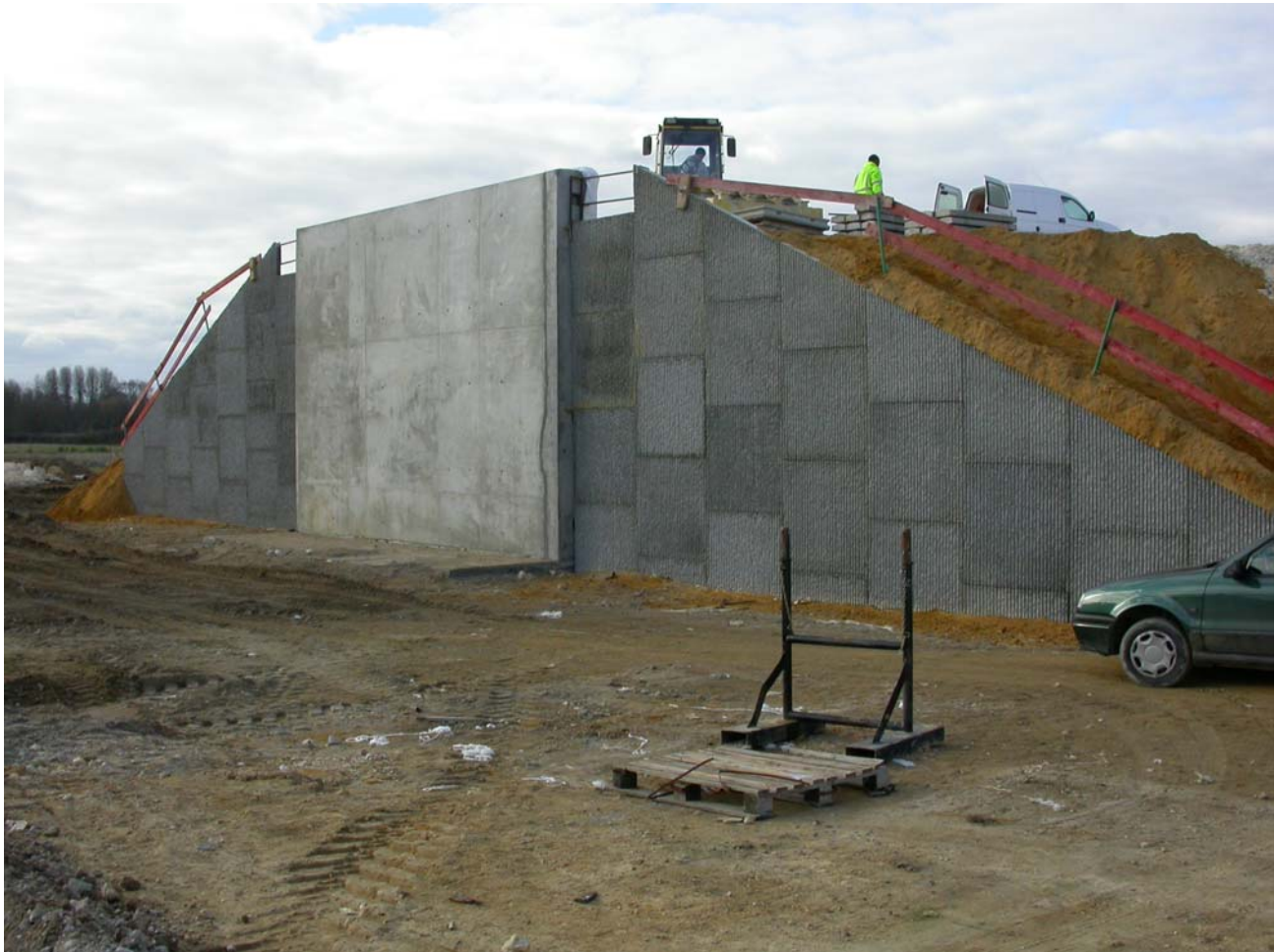
Figure 1. Mur en sol renforcé par nappe de géotextile avec parement constitué de plaques en béton armé.
