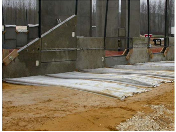
Figure 4. Mise en place du géosynthétique
