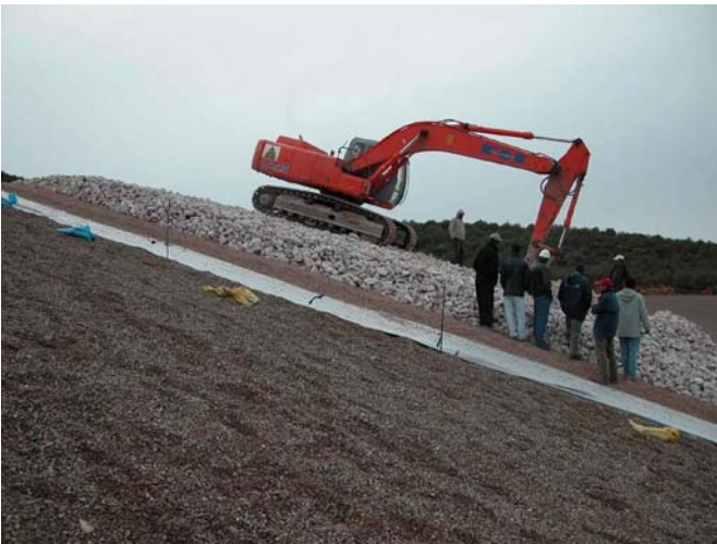
Figure 7. Planche du 22/11/2003 - dégagement de la géomembrane après mise en place de la couche d'enrochements à la pelle mécanique.
