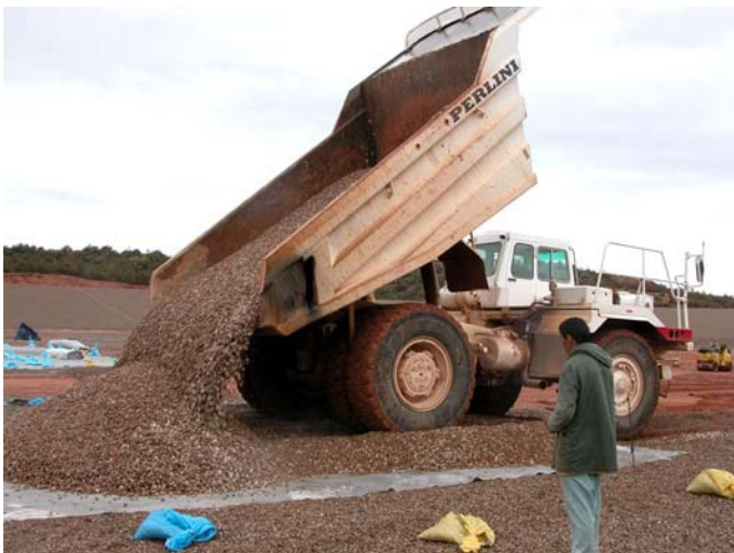
Figure 9. Planche du 22/11/2003. Mise en place sur le fond (gravier roulé 16/32). Solution retenue, ainsi que l'emploi de chargeur à pneu et de niveleuse
