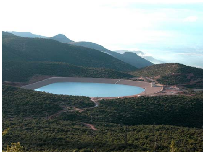
Figure 1. STEP d'Afourer – Bassin supérieur
