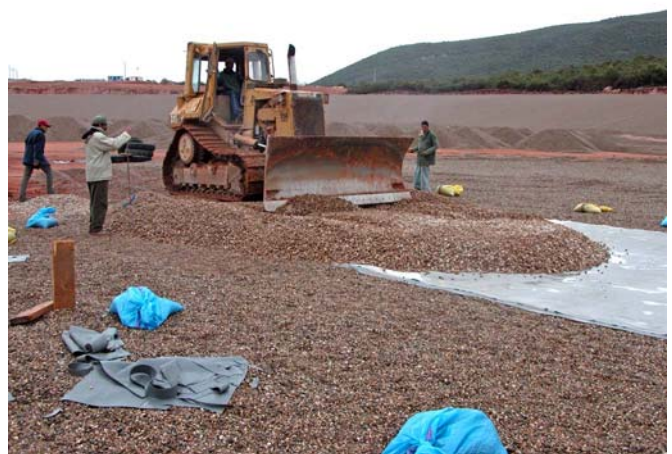
Figure 10. Planche du 22/11/2003. Le tracteur est trop lent sur le fond et ses roues risquent d'être agressives sur talus en cas de sous-épaisseur.
