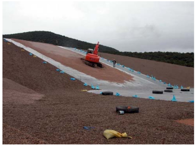
Figures 5 et 6. Planche du 22/11/2003 – mise en place sur talus d'une couche de transition de 0,20 m après réglage de gravier 5/16 concassé. Le support est un 5/16 roulé.
