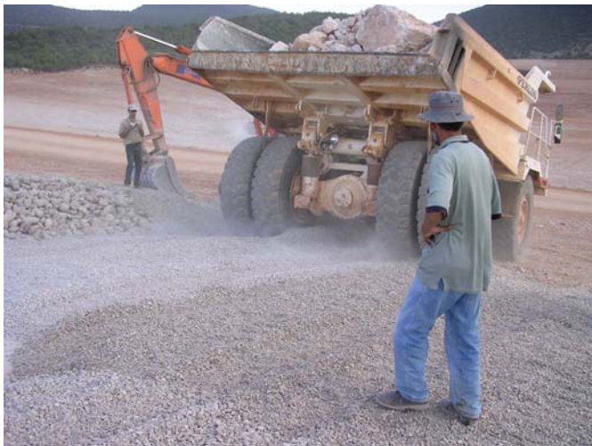
Figure 3. Planche préliminaire. Le dumper circule sur 0,20 m de gravier 5/16, sur un complexe formé par un géotextile, une géomembrane PVC 1,2 mm et un géotextile posée sur une couche de 5/20
