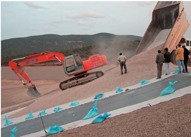
Figures 5 et 6. Planche du 22/11/2003 – mise en place sur talus d'une couche de transition de 0,20 m après réglage de gravier 5/16 concassé. Le support est un 5/16 roulé.
