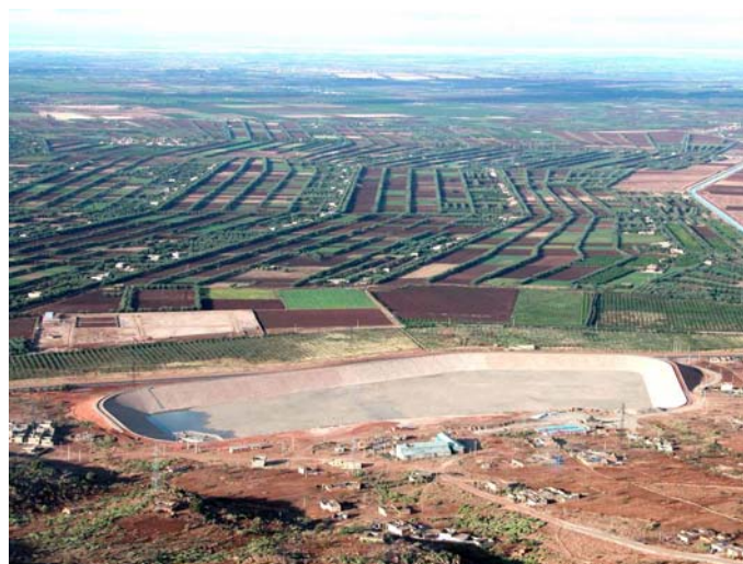
Figure 2. STEP d'Afourer – Bassin inférieur
