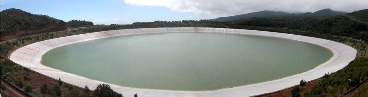
Figure 3 : le bassin de Barlovento en 2004, 13 ans, Géomembrane PVC, 250.000 m<sup>2</sup>, diamètre 600 m
