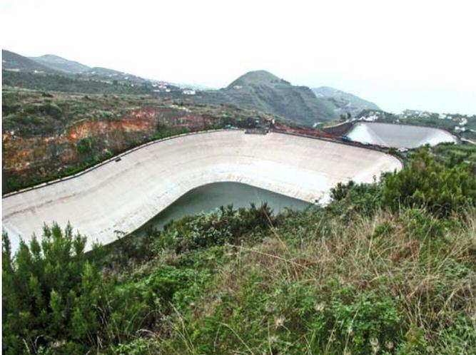
Figure 5 : Vue des bassins d'Adeyahamen et Bedestia réalisés. On remarque l'importance des excavations.
