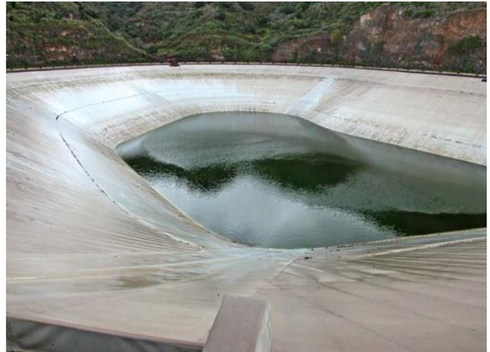
Figure 6 : bassin Adeyahamen partiellement vide ; Profondeur 26 m, pentes 1,5/1. On remarque le premier ancrage sur talus
