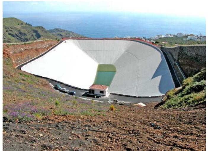
Figure 8 : Bassin de Bedestia vu de la crête de la digue d'Adeyahaman. La route en pied de talus correspond au sommet du massif de pied de renforcement du talus aval de la digue d'Adeyahaman. On observe à droite le renforcement de talus par un mur en blocs cyclopéen.
