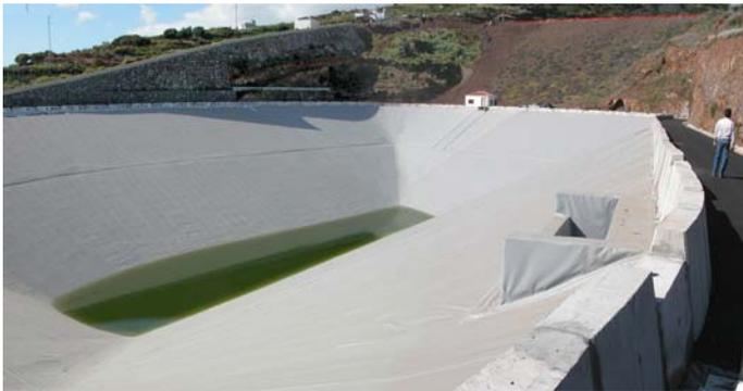
Figure 7 : Bassin de Bedestia vu de l'aval On remarque sur la droite le talus subvertical creusé dans le rocher et sur la gauche le talus renforcé par un soutènement en blocs cyclopéens. On aperçoit au fond la partie supérieure du talus aval d'Adeyahaman. Profondeur : 21 m, pente des talus : 1,5/1
