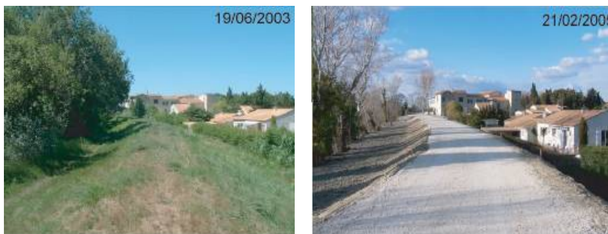
Figure 9. Avant et après le confortement des digues
