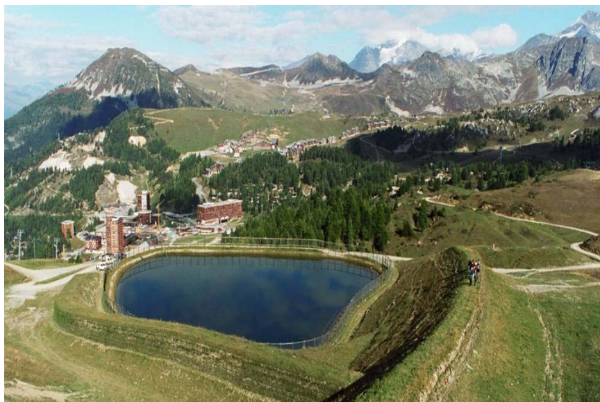
Figure 1. Barrage d'altitude sous (haute) protection paravalanche, dominant une station de ski (P. Mériaux)
