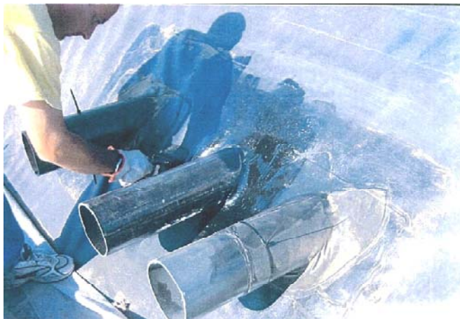
Figures 5 et 6. Raccordement géomembrane EPDM en cours sur canalisations en talus (jusqu'à 6 canalisations par filtre) et sur ouvrage béton - Intérieur 1 er étage filtre planté
