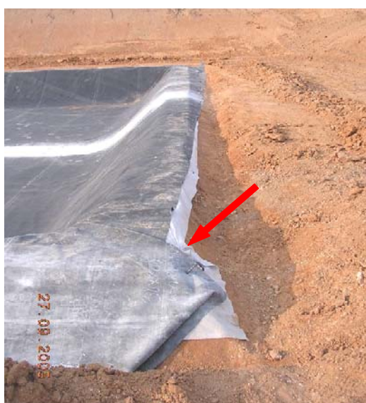
Figure 4. Pour l'EPDM, l'application du principe de précaution doit conduire à une cotation en usine légèrement supérieure aux cotes théoriques de terrassements afin de prévenir tout déficit lors de la mise en œuvre
