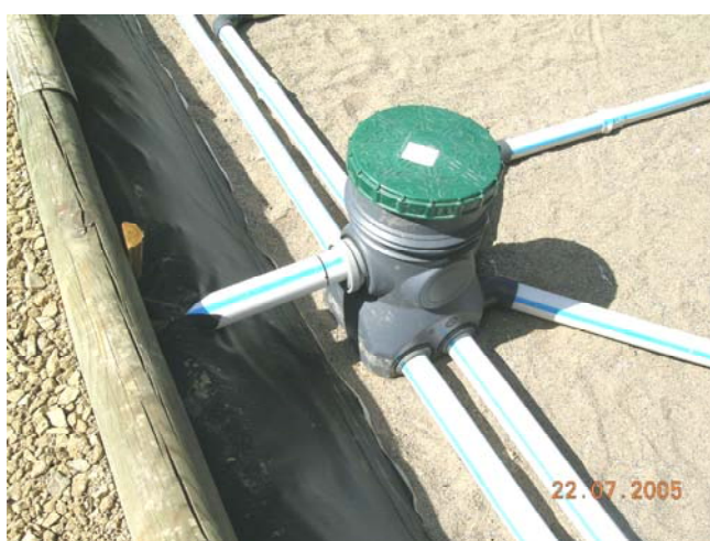
Figures 7 et 8. Dispositifs non conformes de raccordement d'une géomembrane PVC sur canalisation et pieux en bois traité en haut de talus
