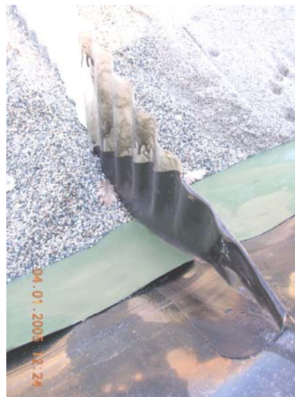
Figure 10. Écran géosynthétique anti racinaire disposé en talus
