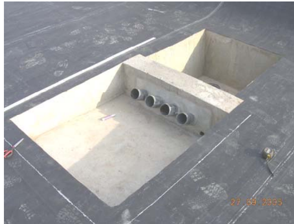
Figures 5 et 6. Raccordement géomembrane EPDM en cours sur canalisations en talus (jusqu'à 6 canalisations par filtre) et sur ouvrage béton - Intérieur 1 er étage filtre planté
