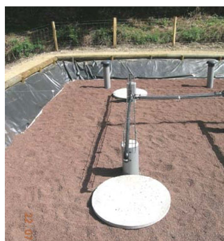
Figures 7 et 8. Dispositifs non conformes de raccordement d'une géomembrane PVC sur canalisation et pieux en bois traité en haut de talus
