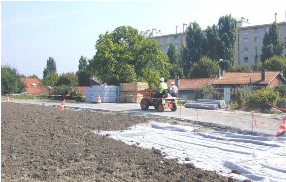
Figure 4. Mise en œuvre de la terre végétale
