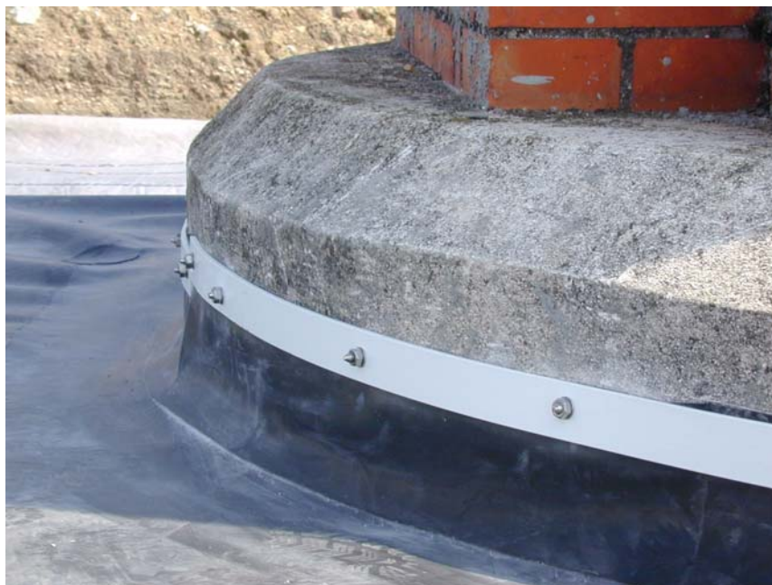
Figure 3. Raccord de la géomembrane sur les émergences
