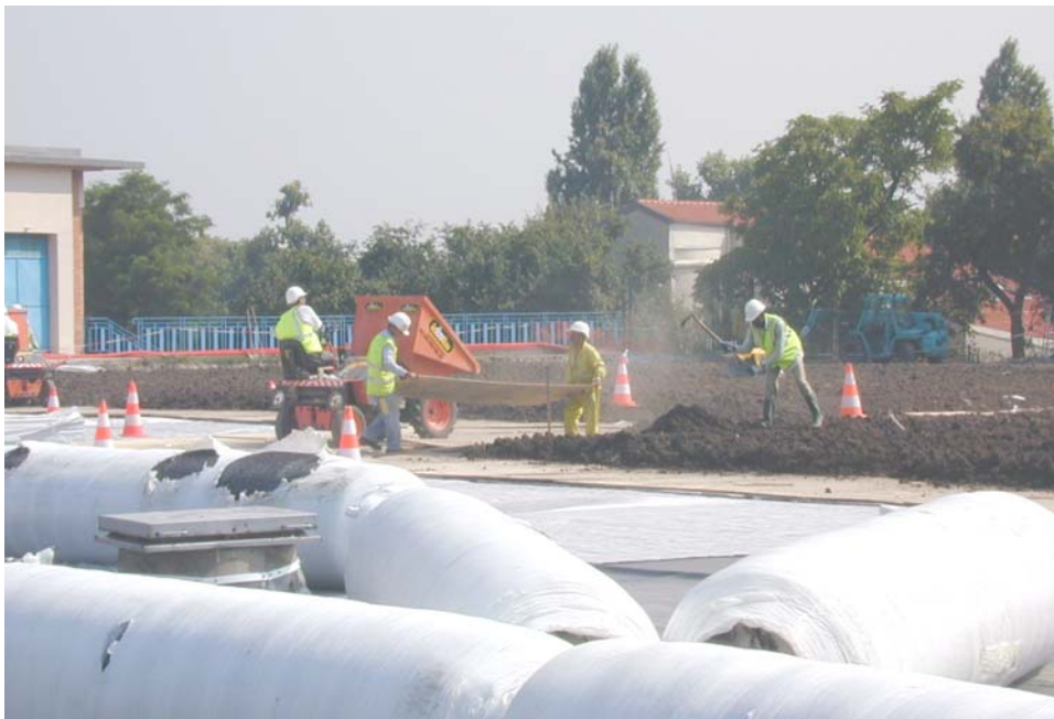
Figure 5. Mise en œuvre de la terre végétale avec circulation sur les chemins de roulement
