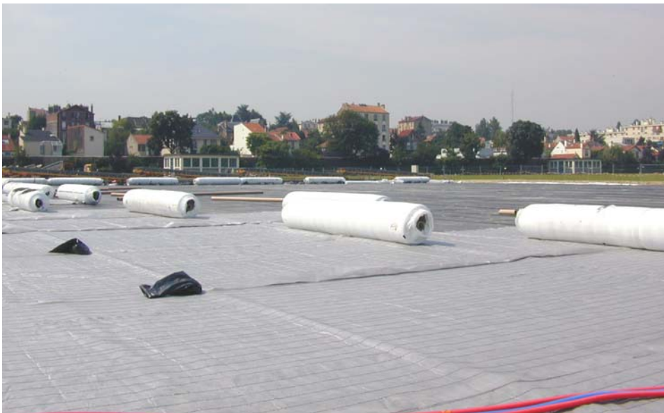
Figure 2. Drainage au premier plan et géomembrane en polypropylène au second plan
