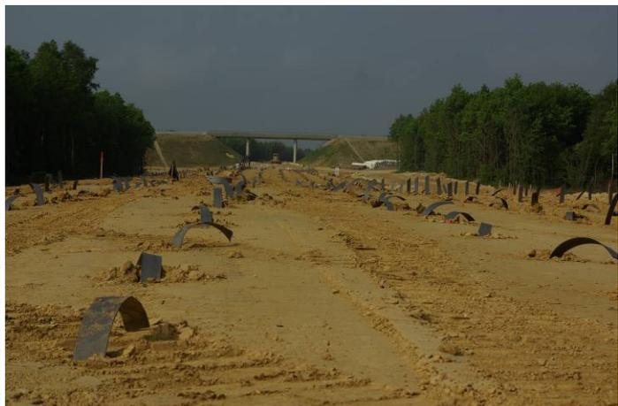
Figures 3 et 4. Mise en place des drains verticaux
