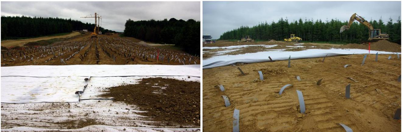
Figures 6 et 7. Mise en œuvre du géocomposite de drainage horizontal et connexion avec les drains verticaux
