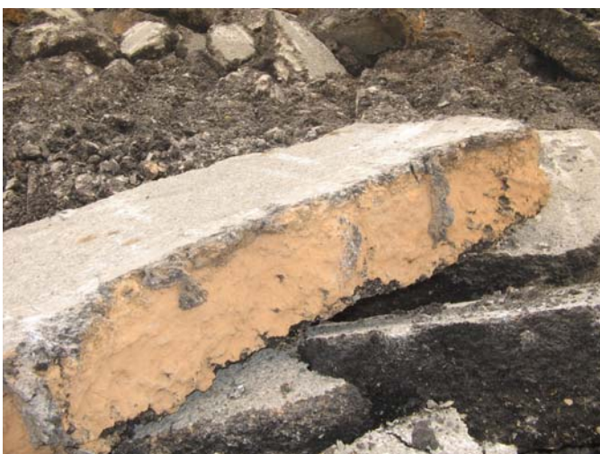
Figure 3. Colmatage défectueux
