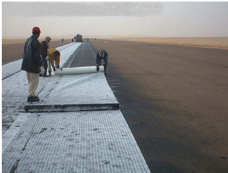
Figure 7. Mise en place de la géogrid
