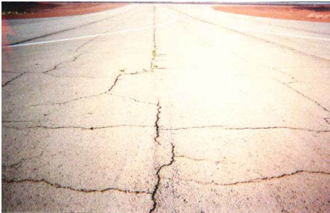
Figure 1. Fissures de retrait thermique
