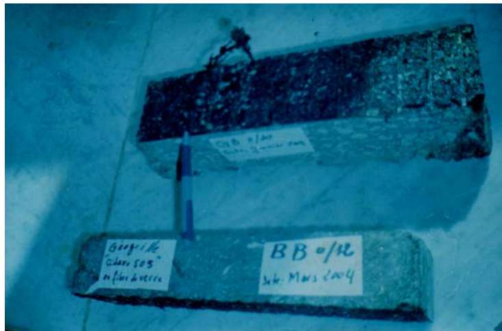
Figure 10. Défaut d'adhésion entre les couches d'enrobé et déchirure de la géogrille
