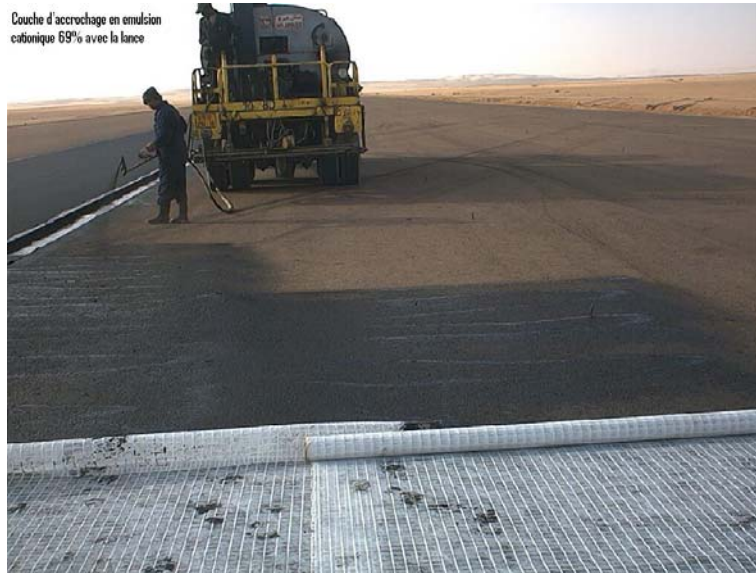
Figure 6. Mise en œuvre de la couche d'accrochage en émulsion
