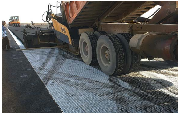
Figure 8. Mise en œuvre de la couche de roulement en BB 0/14
