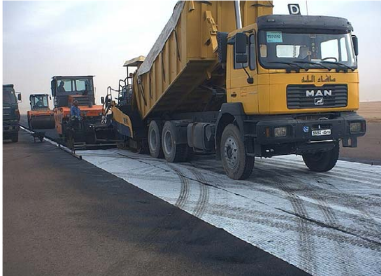
Figure 9. Formation de plis lors du passage des camions
