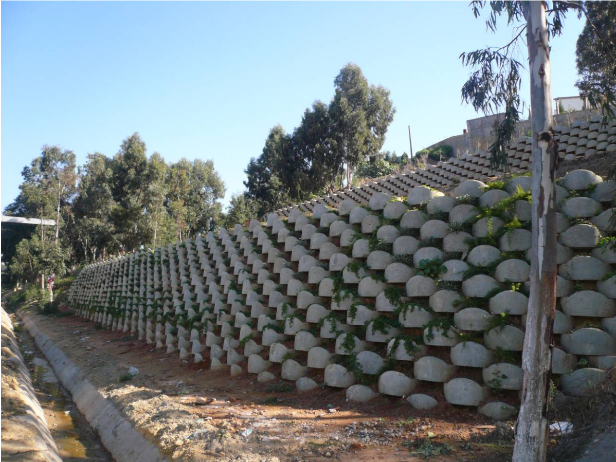
Figure 25. Ouvrage achevé avec la végétalisation
