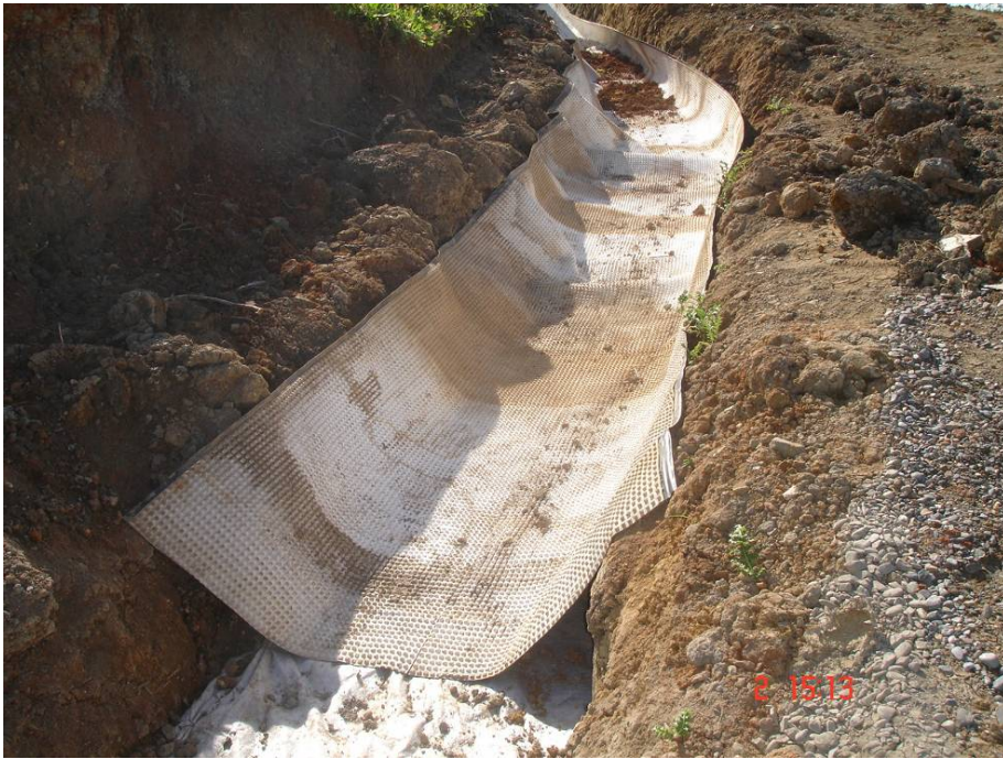
Figure 20. Mise en œuvre du géocomposite étanche
