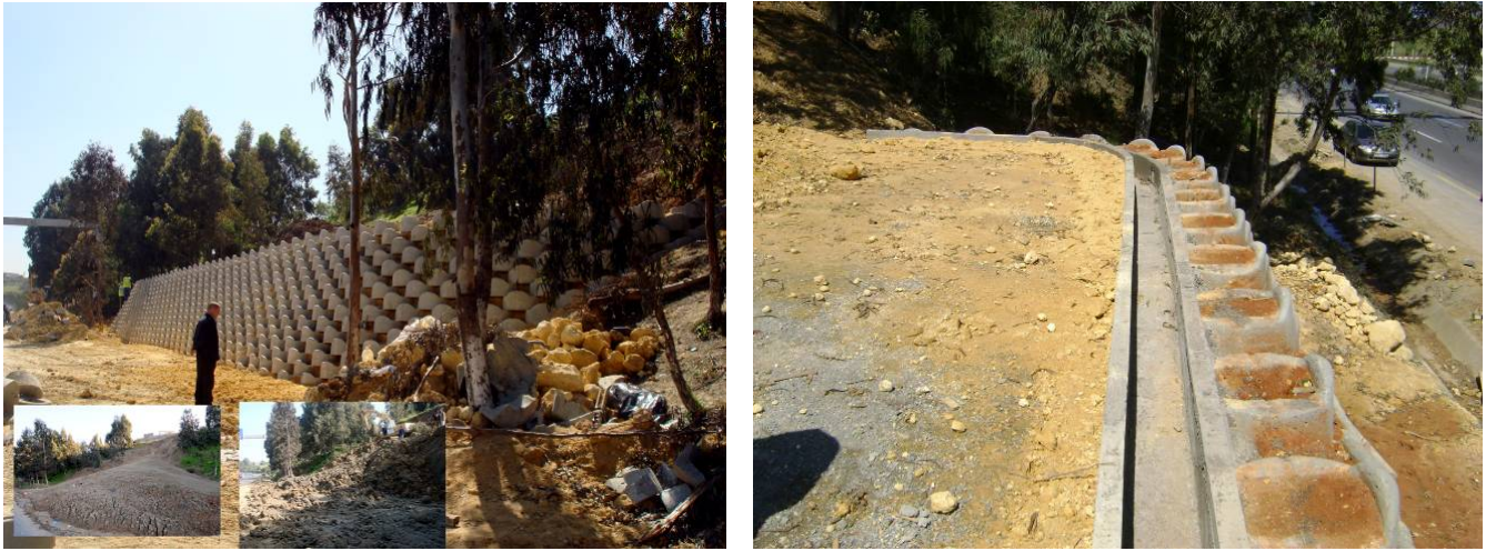
Figures 22 et 23. Ouvrage en phase de construction
