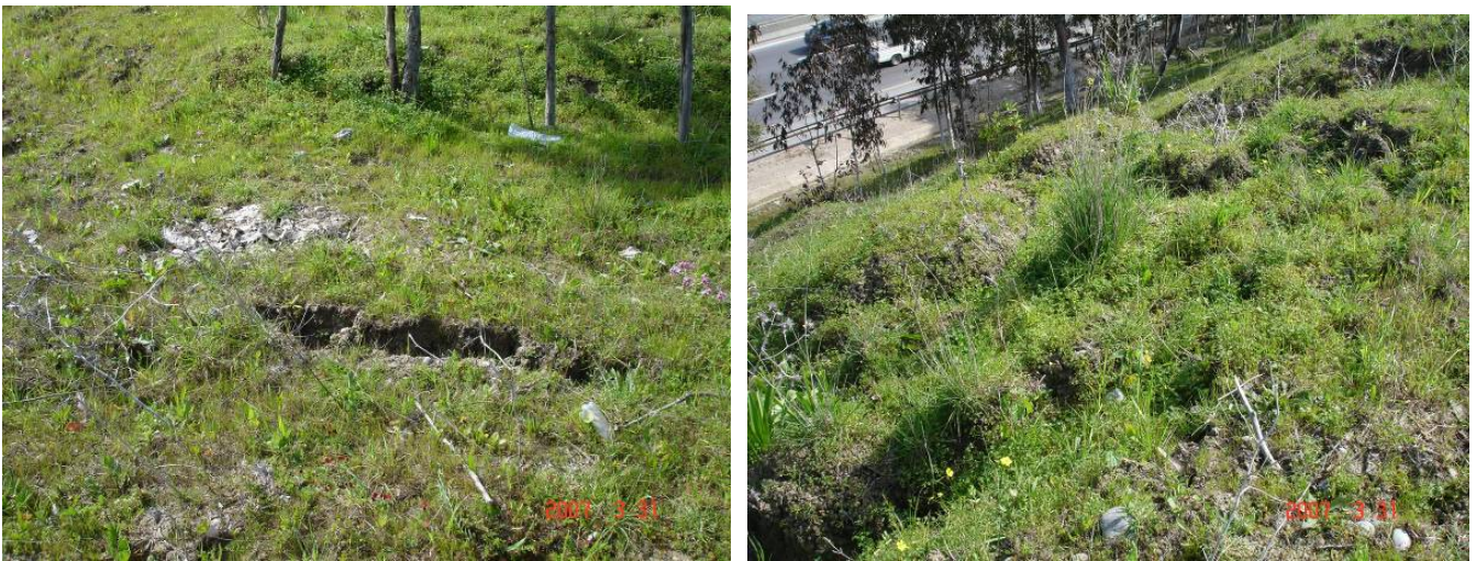
Figures 11 et 12. Nouveaux glissements de part et d'autre de la coulée de boue
