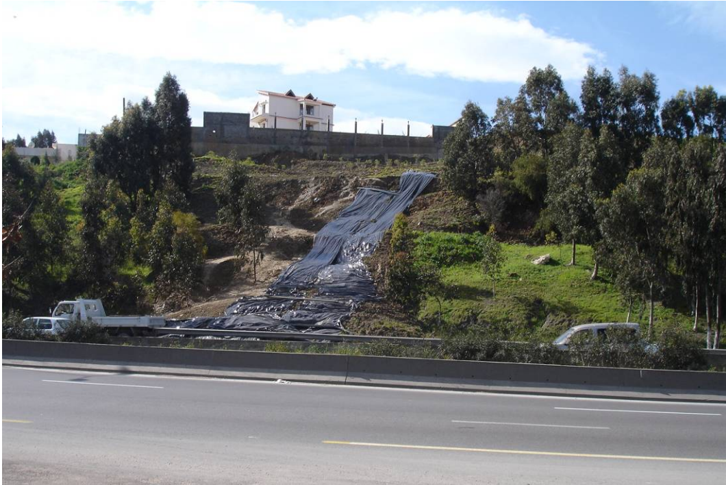
Figure 13. Déboisement total de la zone glissée
