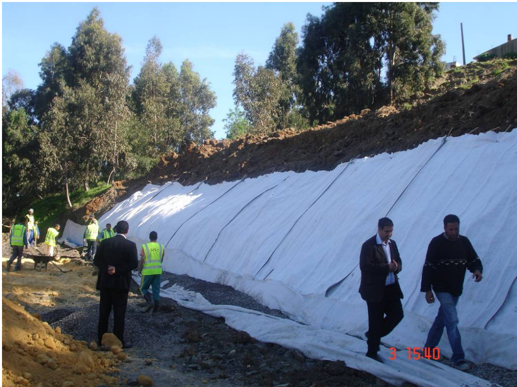
Figure 21. Mise en œuvre du géocomposite de drainage équipé de mini-drains
