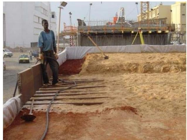
Figure 2. Mise en œuvre d'une couche de remblai
