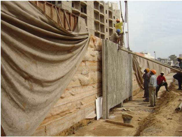
Figure 3. Remblai renforcé avec retour au parement du Géosynthétique
