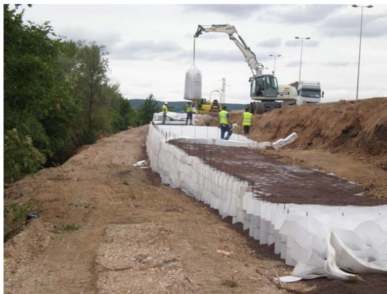
Figure 6. Mise en œuvre des nappes M3S® et de l'argile expansée.
