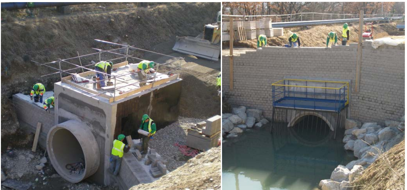
Figure 1. Mur en construction
