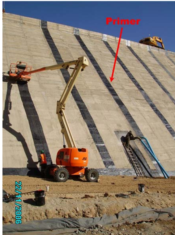
Figure 6. Détails de l'imprégnation de l'émulsion, cas 2
