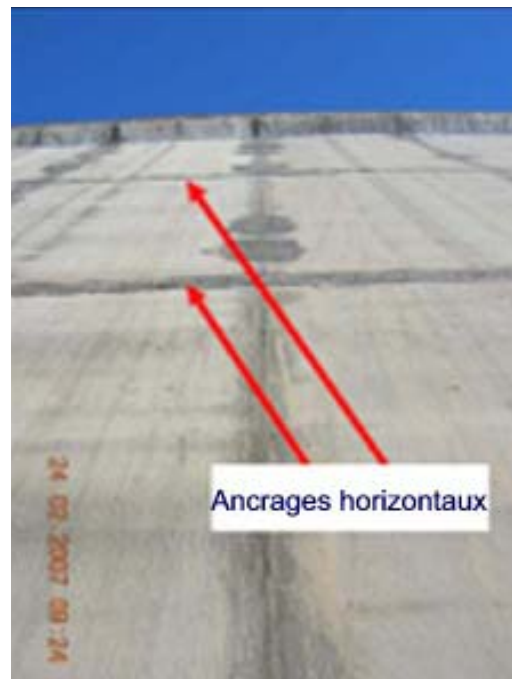
Figure 12. Lignes d'ancrage horizontales des lés en BGM, cas 2
