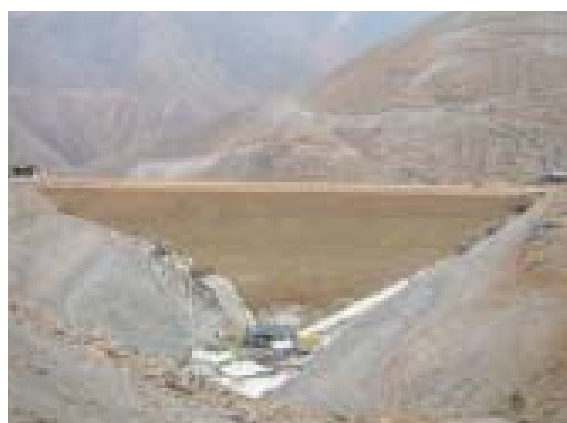
Figure 3. Face amont du barrage, cas 1 – Avant installation
