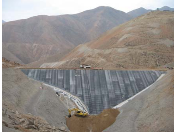
Figure 4. Face amont du barrage, cas 1 – Après installation
