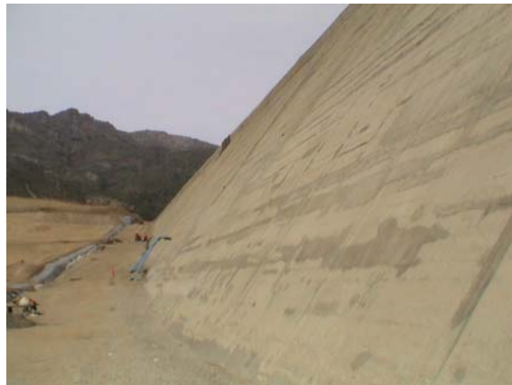
Figure 5. Face amont et détails des réparations, cas 2
