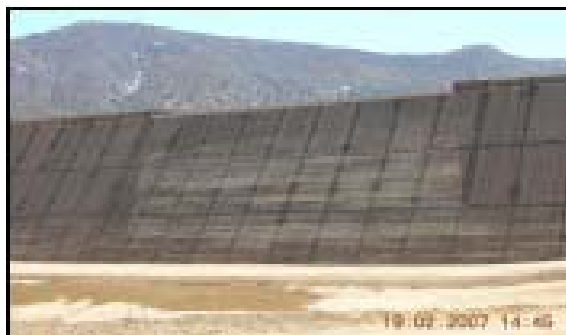
Figure 17. Réparations sur la portion haute du barrage, cas 2
