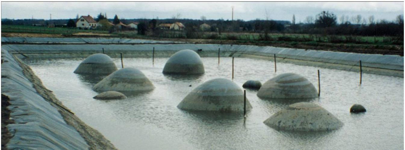
Figure 4. bassin de lagunage en zone marécageuse: le drainage en fond de bassin est noyé et les gaz ne peuvent donc pas s'échapper sur les côtés, même avec des drains supposés leur faciliter la sortie.
