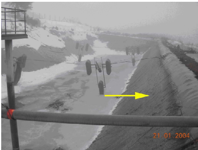
Figure 4. Vue d'ensemble bassin aéré (1) – Absence de déchirures sur le talus exposé au nord
