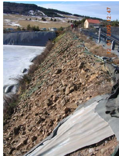
Figure 10. Vue d'ensemble talus nord exposé sud du bassin aéré
