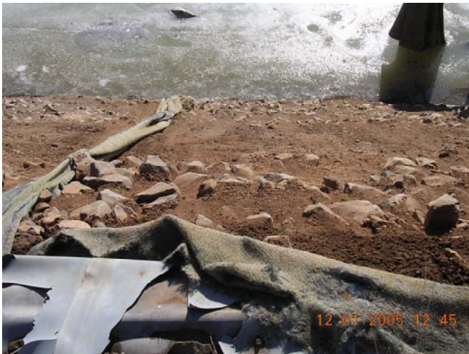
Figure 9. Vue de détail parement talus nord exposé sud du bassin aéré
