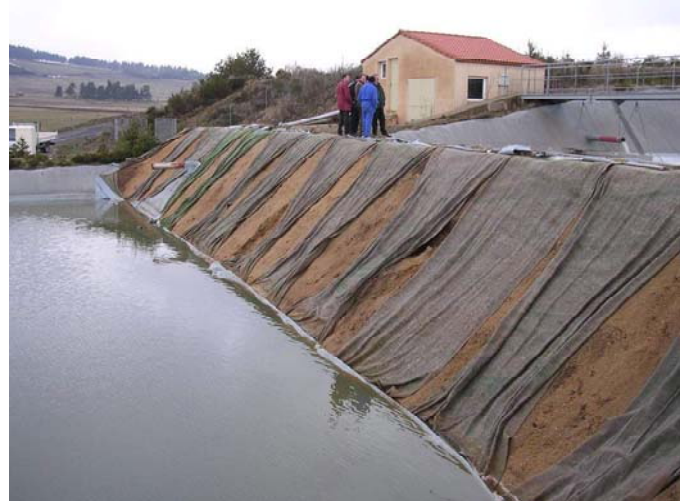
Figure 8. Talus digue médiane exposé sud entre bassin 1 et bassin 3
