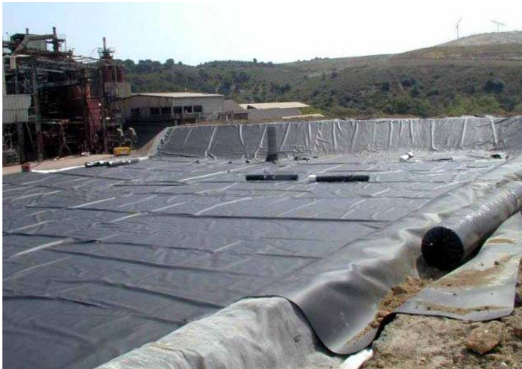
Figure 3. Pose de la géomembrane en PEHD GEONAP dans l'alvéole étanche
