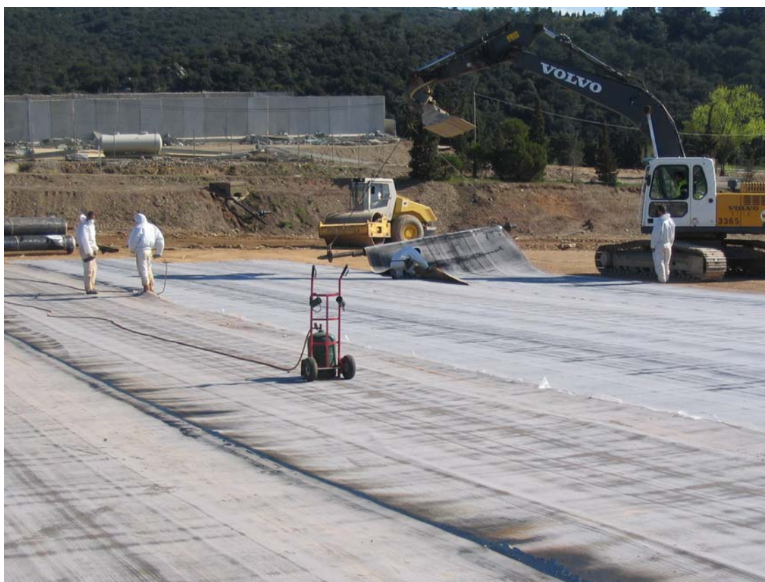
Figure 4. Pose de la géomembrane bitumineuse en couverture
