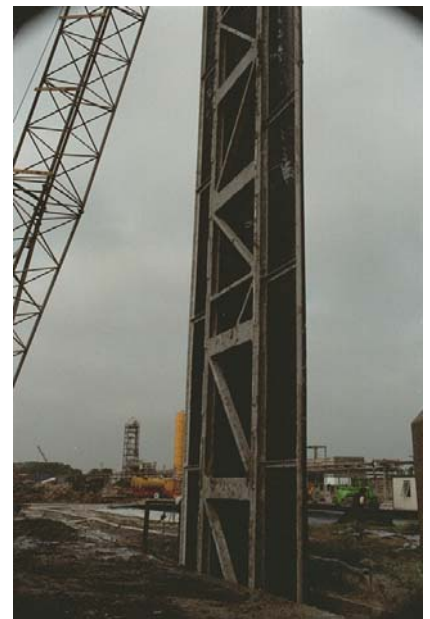
Figure 13. Contrôle de la descente du panneau sur son portique de guidage
