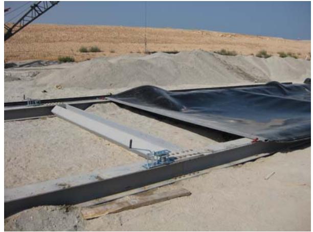
Figure 9. Mise en tension de la palfeuille
