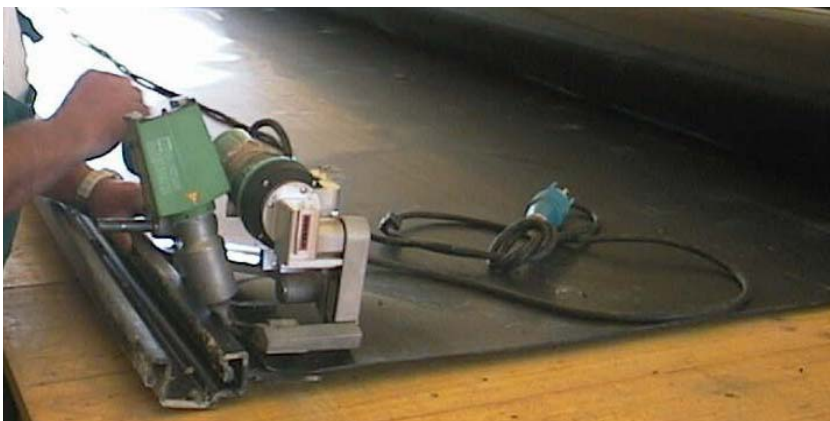
Figure 2. Soudure de la clé et de la géomembrane
