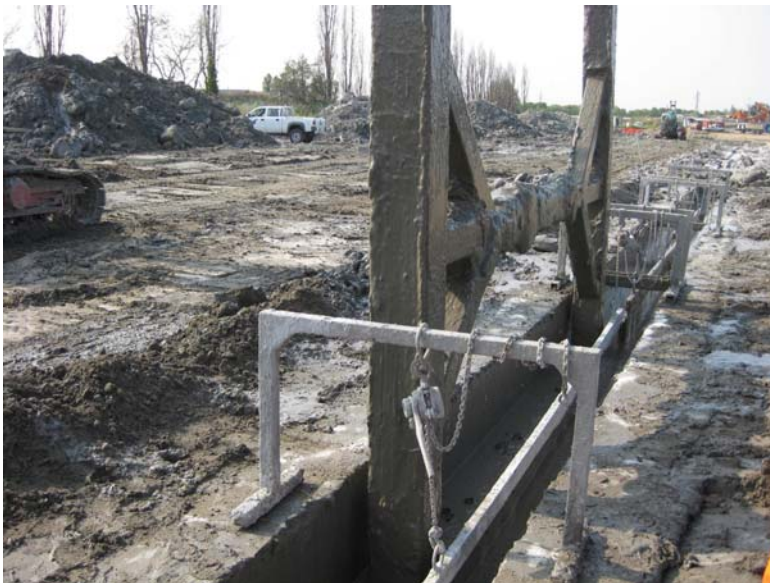
Figure 16. Maintien des palfeuilles tendues et remontée du portique
