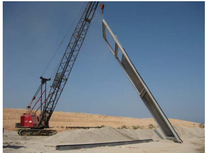
Figure 7. Amenée de la palfeuille au droit de la tranchée
