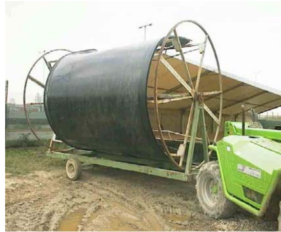
Figure 5. Enroulage d'un panneau préfabriqué
