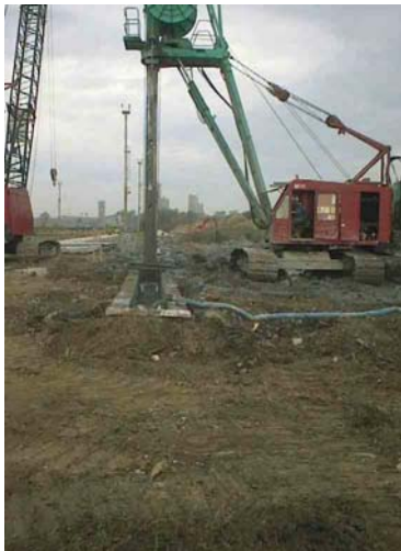
Figure 6. Terrassement de la fouille. Vue des murettes guide
