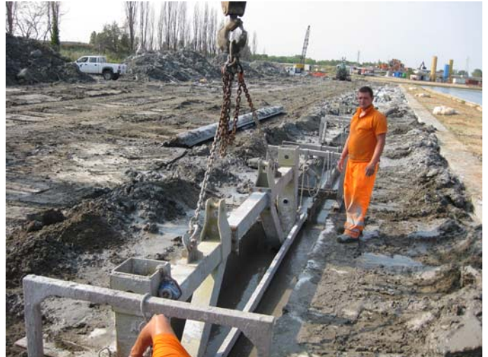
Figure 15. Le panneau est entièrement descendu
