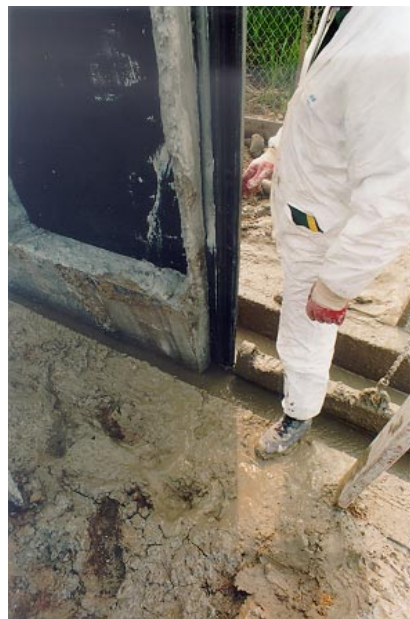
Figure 13. Contrôle de la descente du panneau sur son portique de guidage
