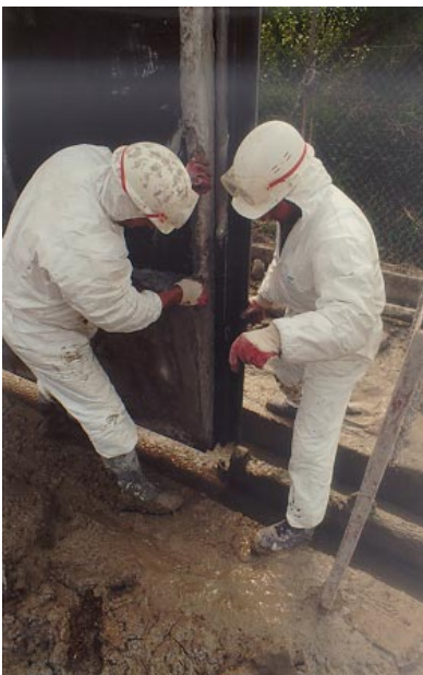
Figure 12. Emboîtement des clés
