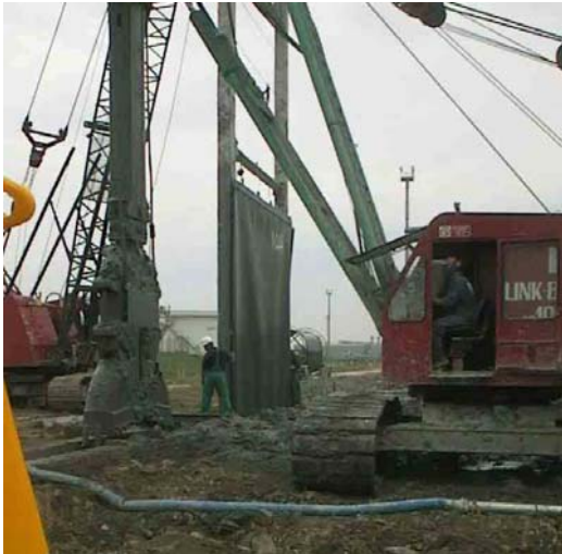
Figure 14. Descente d'un panneau + ouverture simultanée de la tranchée
